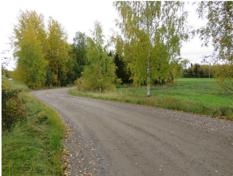
Voimajohtolinjauksen ylityspaikka Haaksiluodontien kohdalla, kuva koilliseen.
