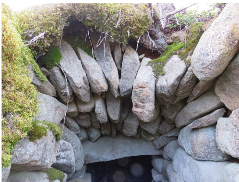
Kellarin oviaukon yläosa.
