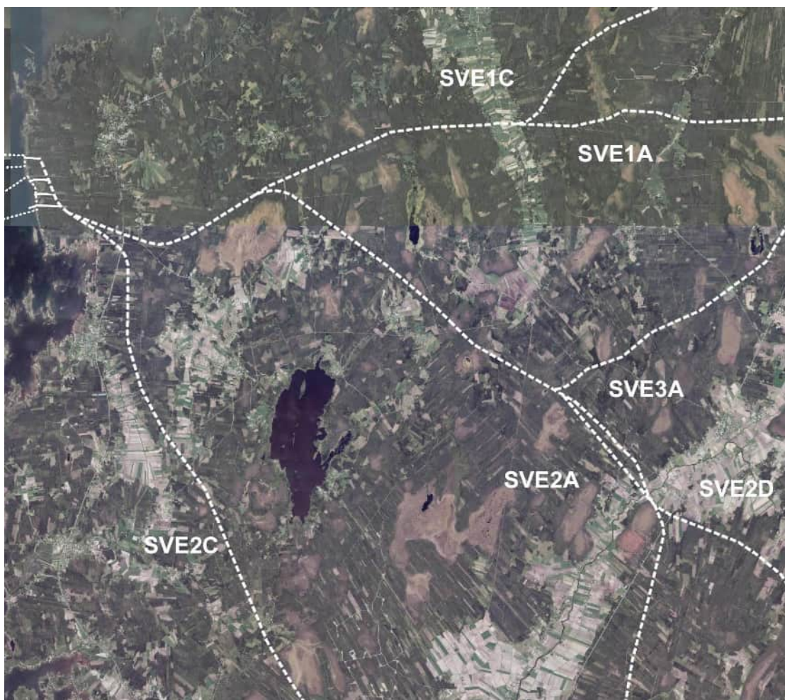
Figur 11-2. Flygfoto över området för kraftledningarna.
