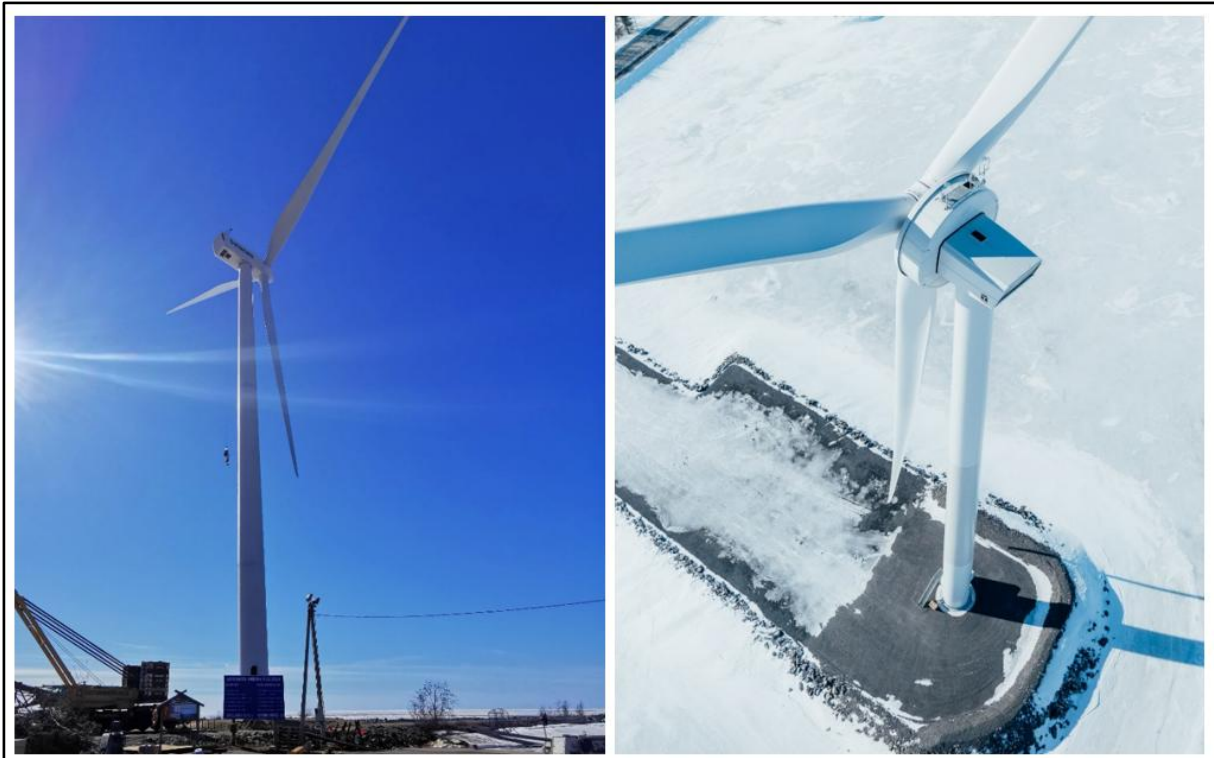
Kuva 9. Vasemmalla tuulivoimalan rakentaminen ja oikealla tuulivoimala perustuksineen (Solarwind Finland Oy).
