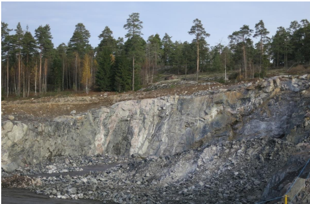
Kuva 5-25. Nykyinen kallioulouhinta-alue hankealueella. Louhinnan jälkiä kallioselänten reunalla. Louhintaa tehdään pieni alue kerrallaan, jolloin aktiivisen toiminnan alueet jäävät suhteellisen pieniksi. (Kuva: Sarlos 2013)
