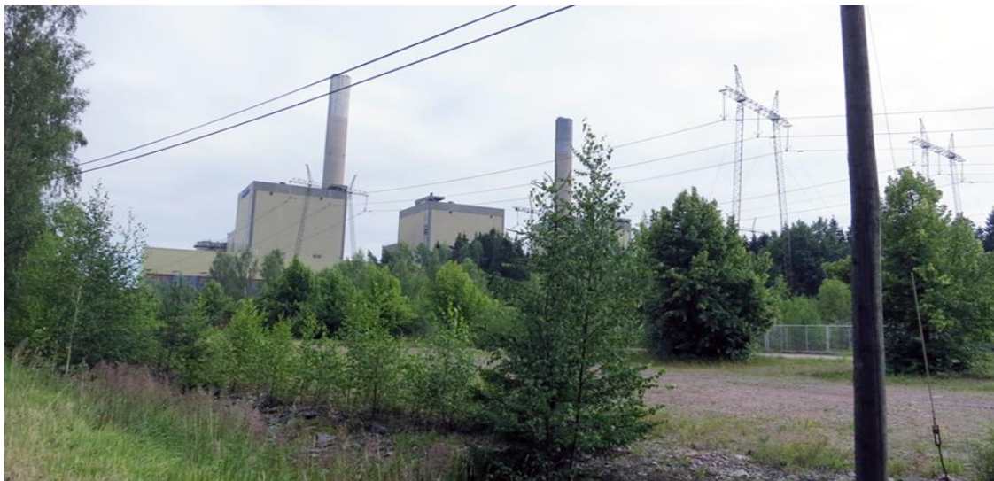
Bild 5-13. Kraftverksbyggnaden med närområdet avbildade från sydväst mot sydöst. (Bild: Sarlos 2012)
