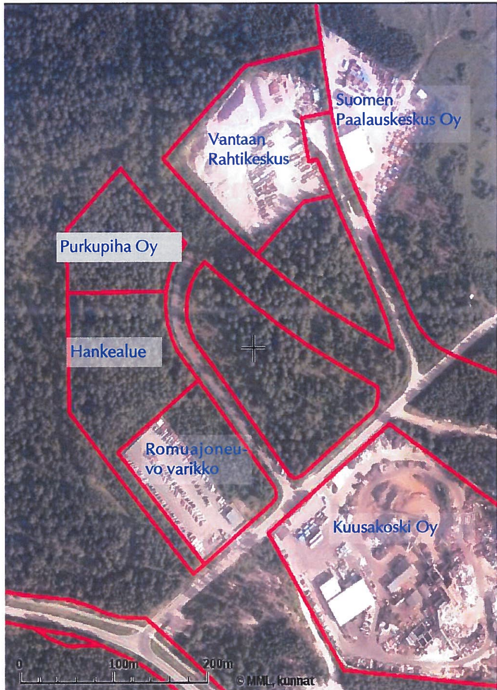
Kuva 9. Ilmakuva, Kiinteistö tietopalvelu
