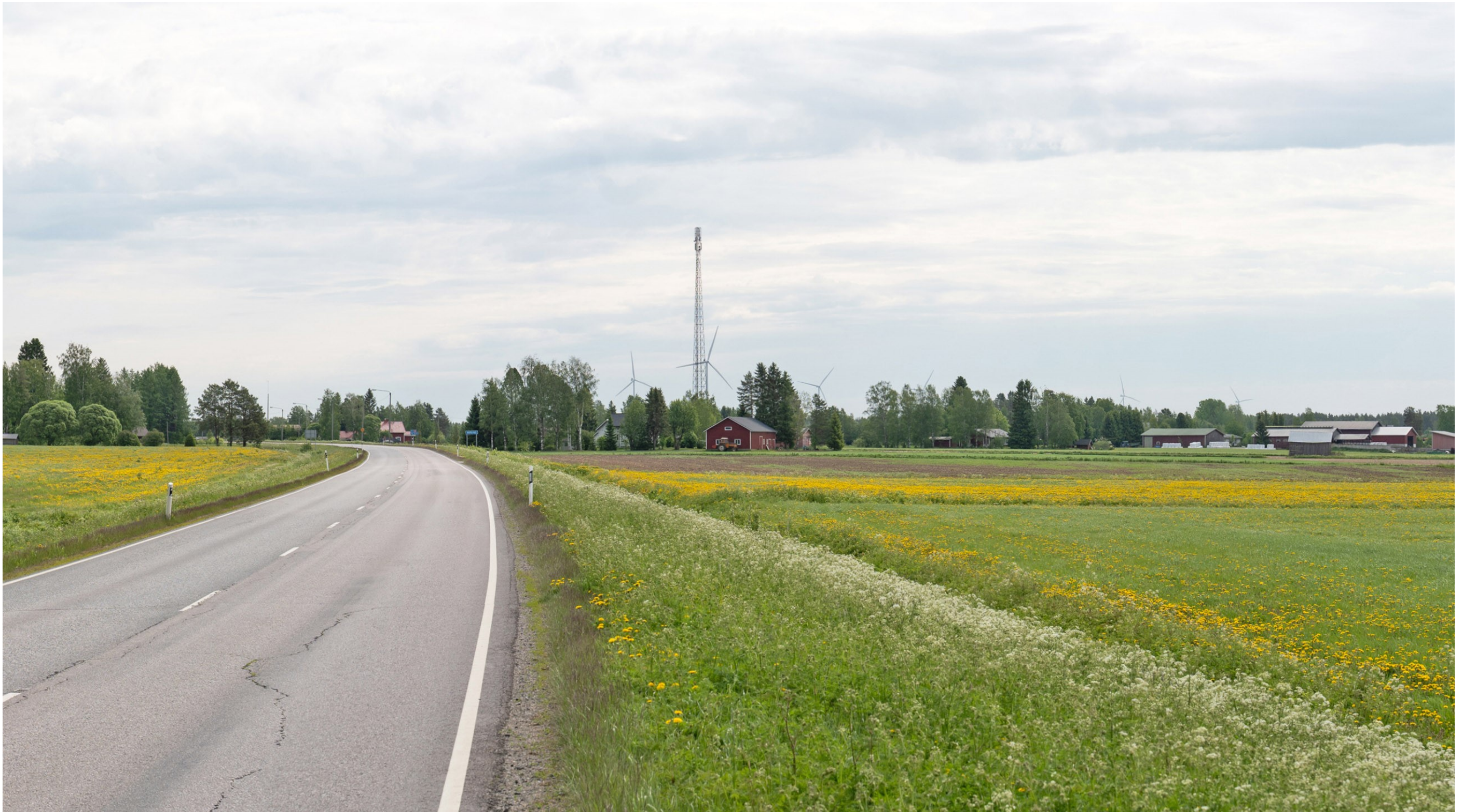
Kuva 11.4. Havainnekuva Karsikkaalta (VE1). Kuvakulma vastaa kinofilmikoon 50 mm objektiivin kuvakulmaa. Riitamaa-Nurmesnevan voimalat eivät näy maisemassa. Maisemassa näkyy Hankilan tuotannossa olevia voimaloita.
