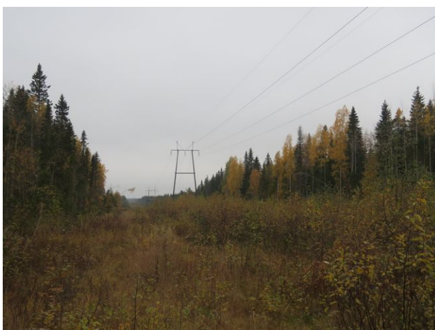
Kuva 12. Liitymiskohta Pyhäjärvi–Vuolijoki voimalinjan käytävälle.
