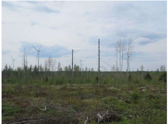
Kuva 14. Linjaus Paalurämeen kohdalla, lounaaseen.
