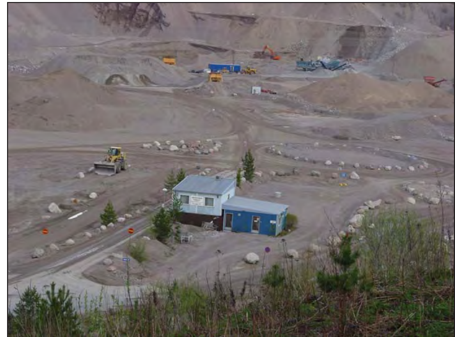
Kuva 4-3. Renkomäen vaaka-asema. Taustalla näkyy myös murskaus- ja seulonta-asema.
