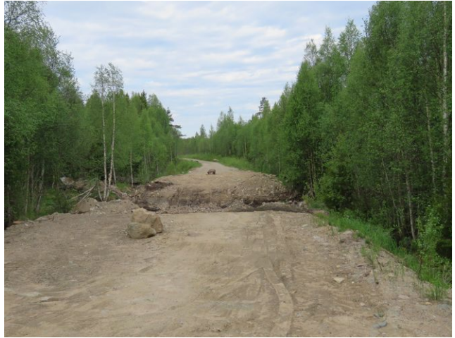
Kuva 6. Vähätainiojen yli mennyt tiesilta on purettu hankealueen kaakkoisreunalla.
