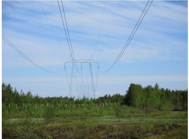
Kuva 34. Keminmaa–Pyhänselkä-voimalinja. Kuva on otettu hankelinjan liittymäkohdasta, 2 km eteläisemmän kaatopaikka-alueen eteläpuolelta.
