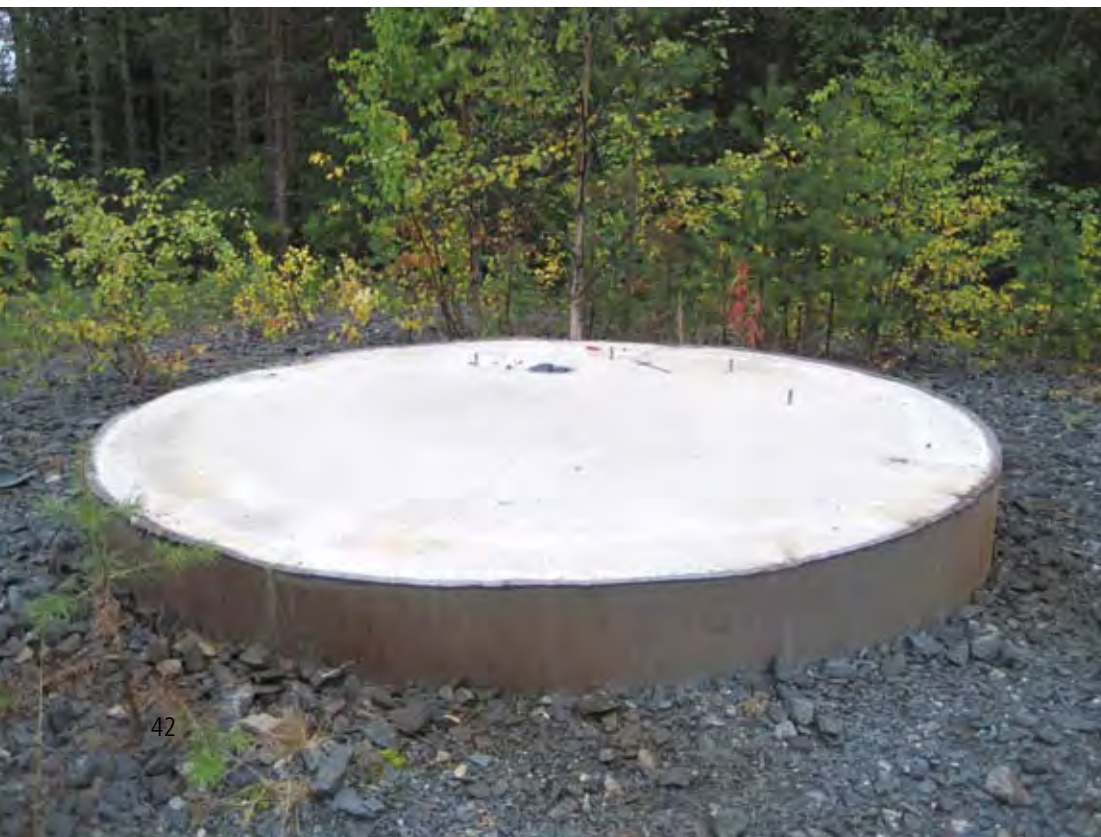
Kuva 6-3 Puretun voimalan perustukset.
