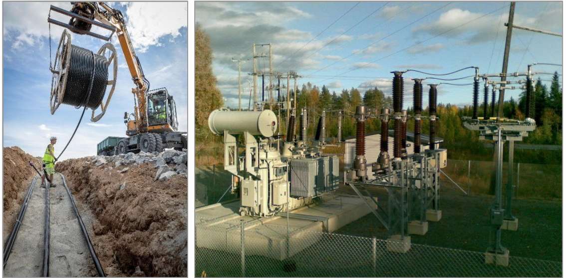
Kuva 4-2. Maakapelin laskemistyöt (vasemmalla) © OX2 / Joachim Lagercrantz ja esimerkki tuulivoimahankkeen 20/110 kV sähköasemasta (oikealla) © Pöyry Finland Oy.
