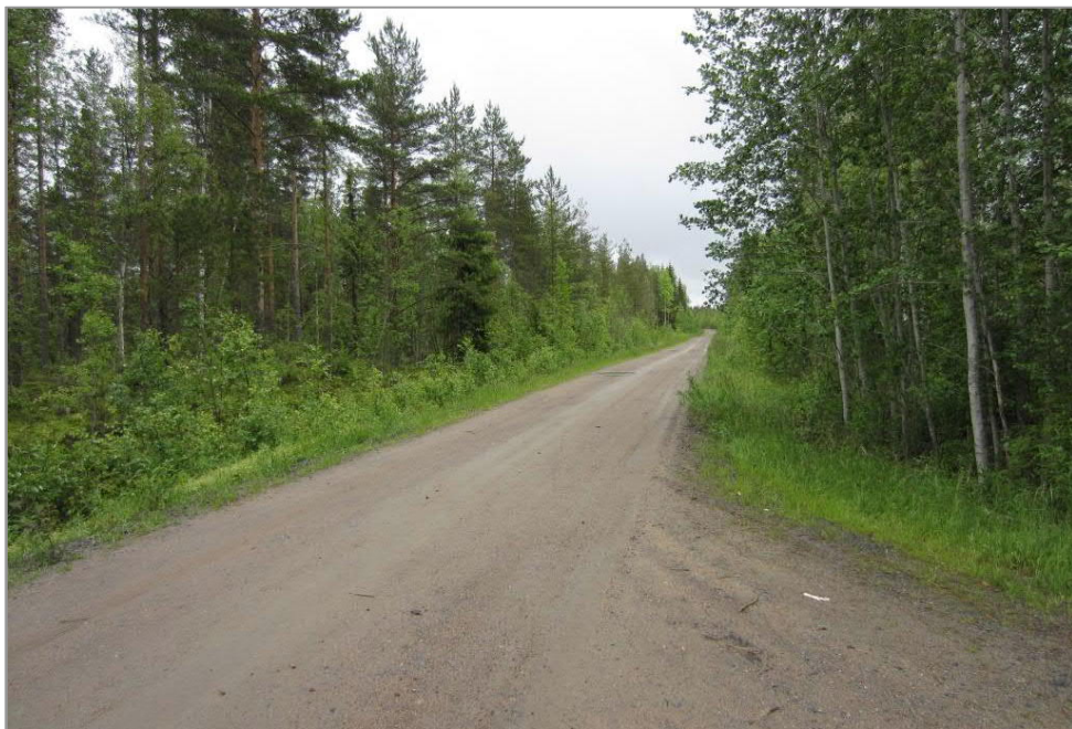
Kuva 4-3. Esimerkki tuulipuiston rakennus- ja huoltotiestä. © Pöyry Finland
