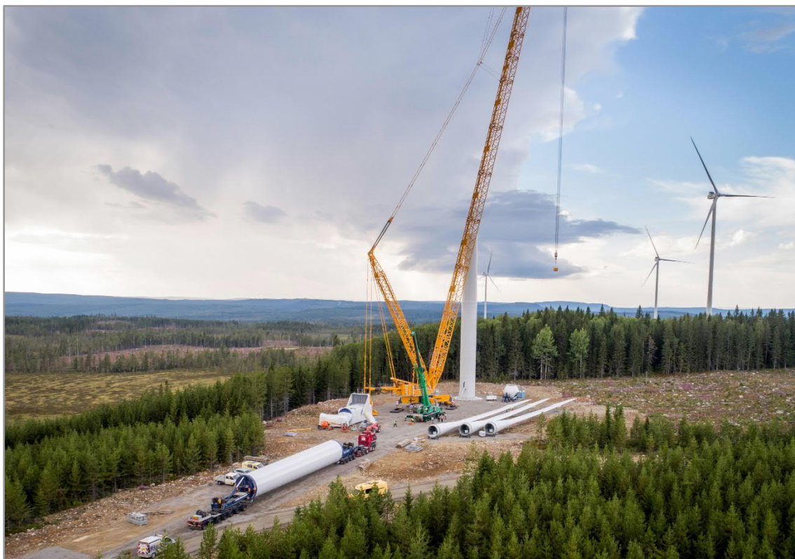
Kuva 4-4. Tuulivoimalan kokoaminen. © OX2 / Joachim Lagercrantz
