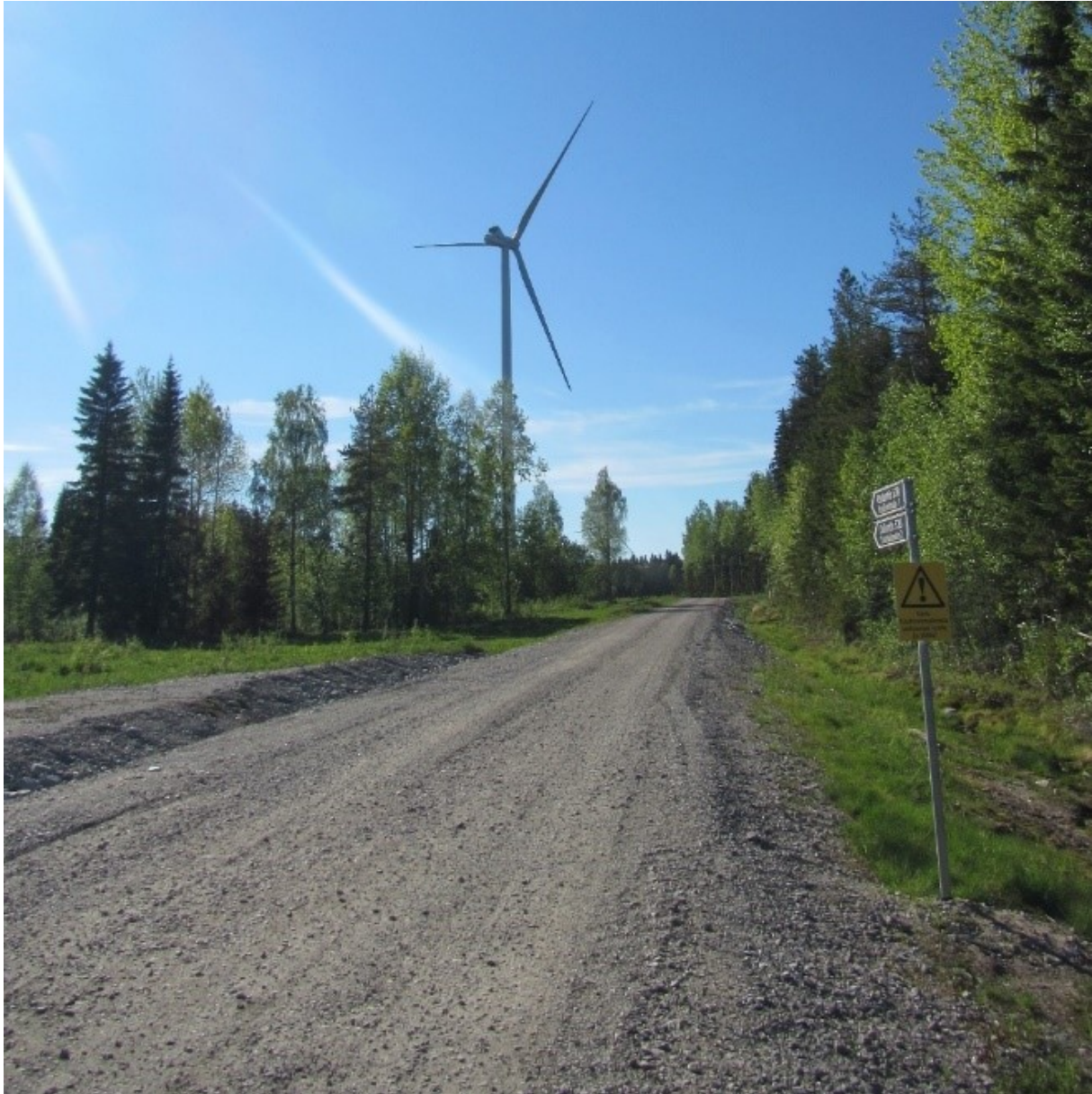
Kuva 3-6. Esimerkki tuulivoiman tuotantoalueen rakennus- ja huoltotiestä. Kuva: © AFRY Finland Oy.
