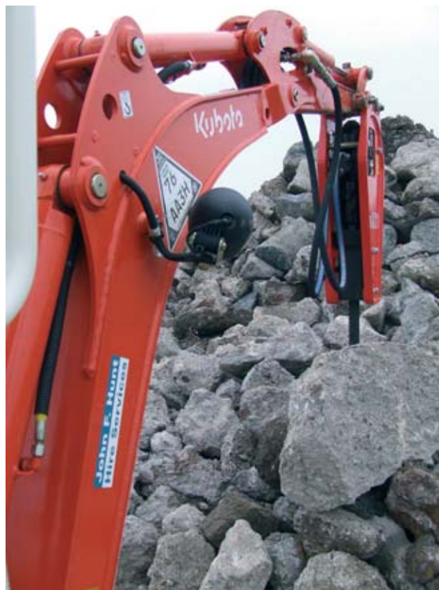
■ Kuva 3.5 Hydraulinen iskuvasara rikottamassa.
