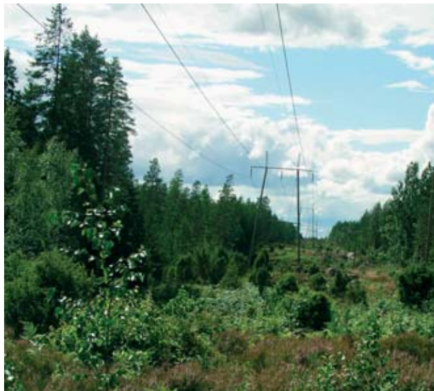
■ Kuva 5.8 Hankealueen eteläpuolella oleva voimalinja.
