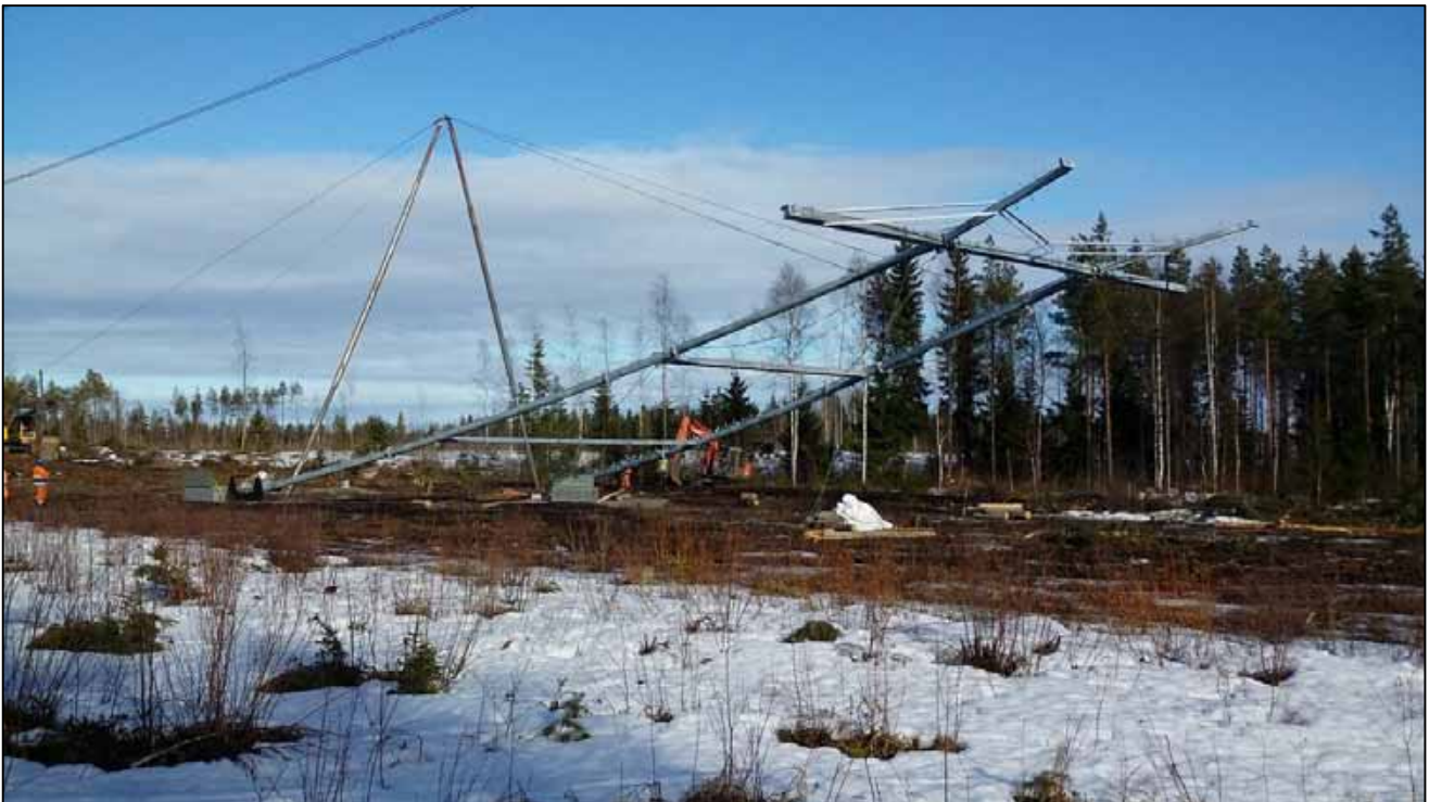
Kuva 9. Voimajohtopylvään pystytys.
