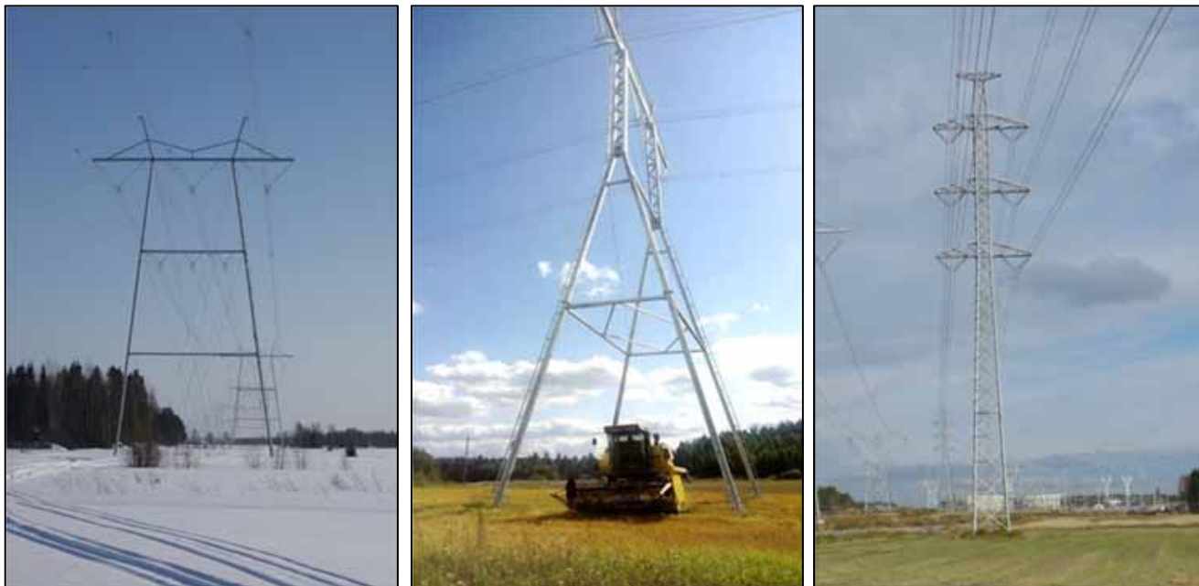
Kuva 27. Esimerkkejä eri pylvästyypeistä. Vasemmalla 400+110 kilovoltin haruksin tuettu teräksestä valmistettu portaalipylväs, keskellä vapaasti seisova harukseton peltopylväs ja oikealla vapaasti seisova t-pylväs.
