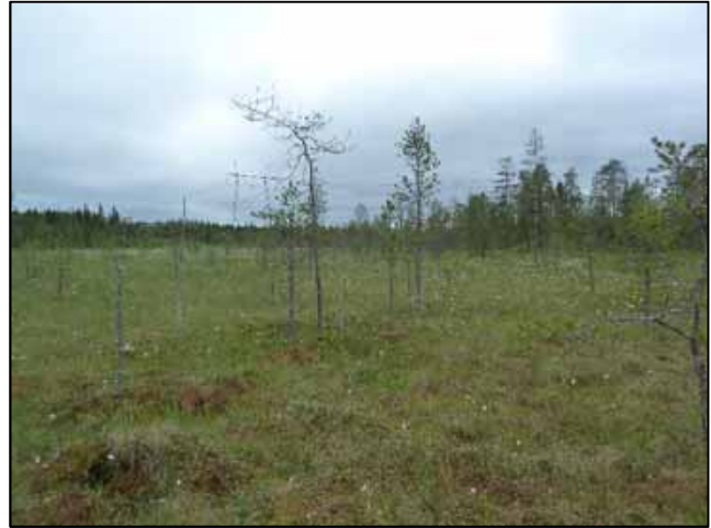
Kuva 77. Avoisuuksissa voimajohtorakenne voi erottua kauas, joskin etäisyyden kasvaessa voimajohtorakenteiden erottuvuus heikkenee. Kaukomaisemassa lähinnä pylvää erottuvat.
