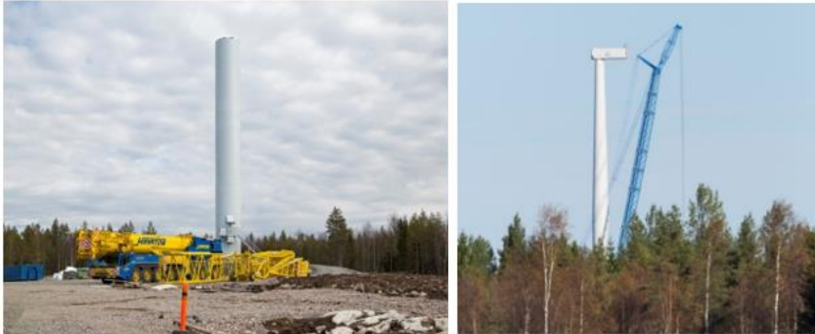
Kuva 37. Tuulivoimalan kokoamista (kuvat: FCG).
