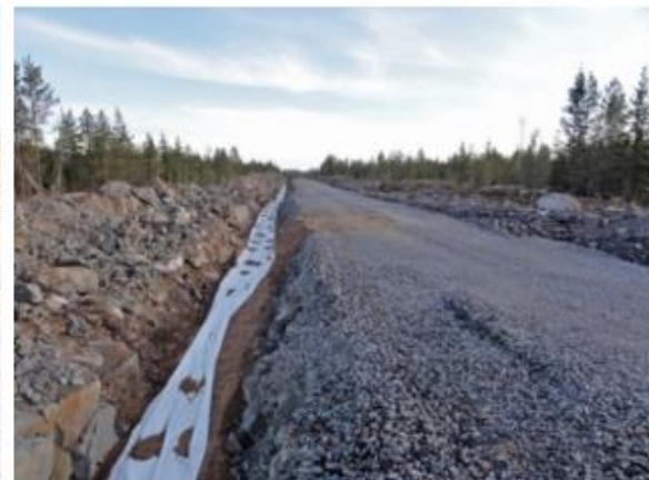
Kuva 35. Maakaapelit upotetaan huoltoteiden yhteyteen (kuvat: FCG).
