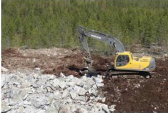
Kuva 34. Tuulivoimapuiston rakentaminen alkaa huoltoteiden ja pystytysalueiden rakentamisella (kuvat: FCG).
