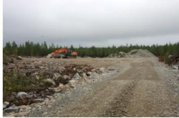
Kuva 34. Tuulivoimapuiston rakentaminen alkaa huoltoteiden ja pystytysalueiden rakentamisella (kuvat: FCG).
