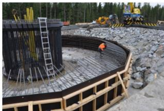
Kuva 36. Tuulivoimalan perustusten rakentamista (kuvat: Leila Väyrynen, FCG).
