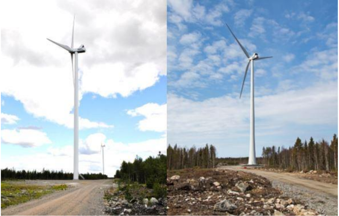
Kuva 26. Vasemmalla on esimerkki teräslieriötornista ja oikealla hybriditornista (Kuvat: FCG).
