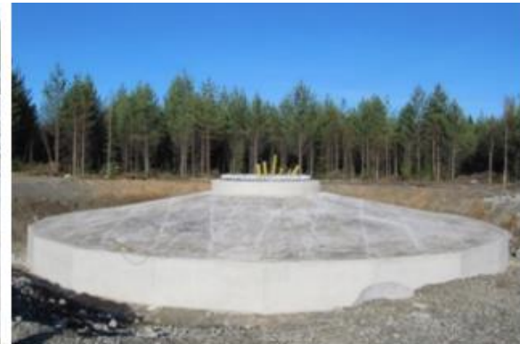
Kuva 36. Tuulivoimalan perustusten rakentamista (kuvat: Leila Väyrynen, FCG).
