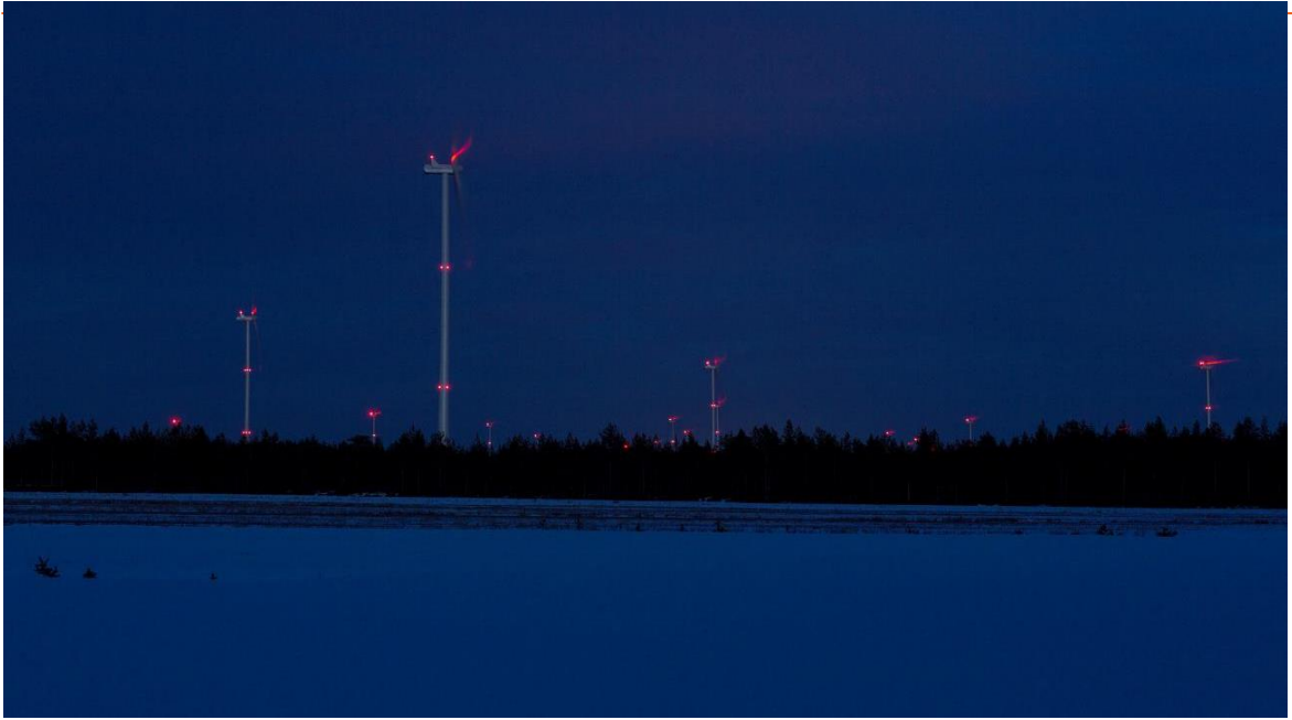
Kuva 29. Kiinteät punaiset lentoestevalot (kuva: FCG).
