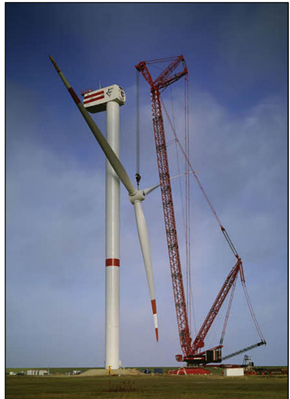
Kuva 3-11. Tuulivoimalan pystytys tela-alustaisella nosturilla (Liebherr).
