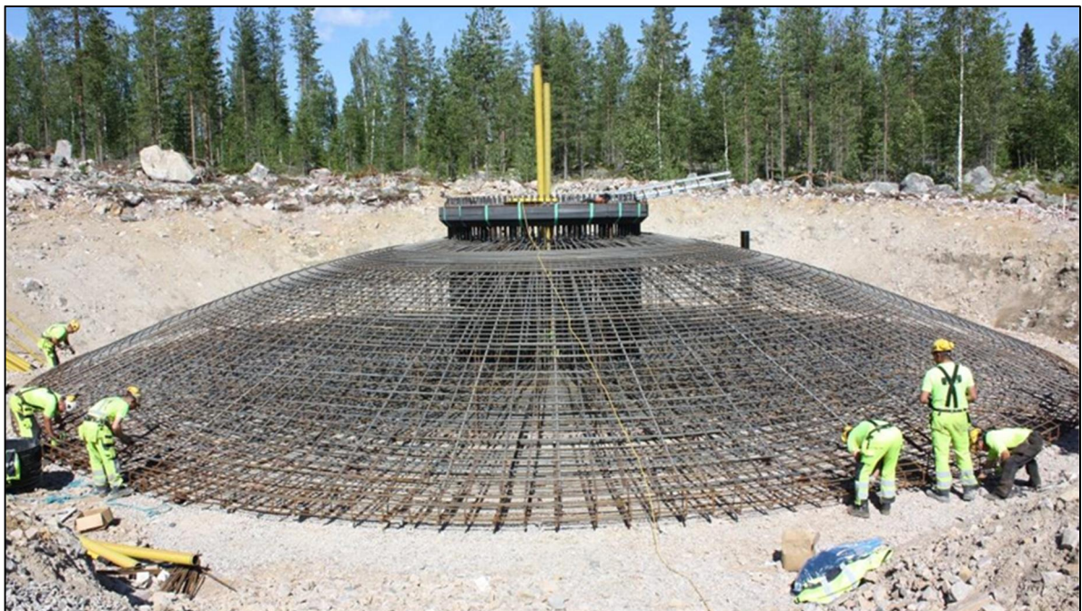
Kuva 3-7. Maanvarainen teräsbetoniperustus raudoitettuna ennen betonivalua.
