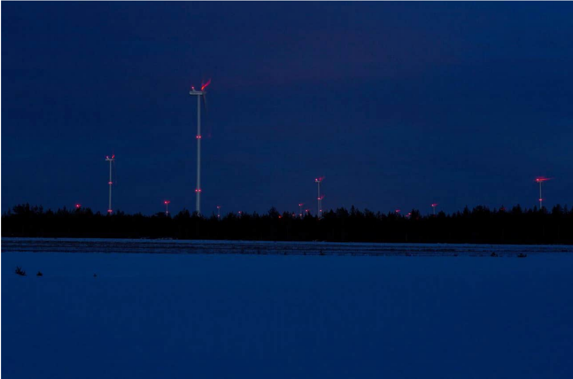
Kuva 4.5. Kiinteät punaiset lentoestevalot. (Kuva: FCG)
