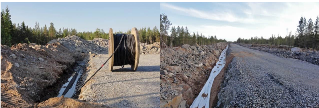
Kuva 4.14. Maakaapelit upotetaan huoltoteiden yhteyteen (kuvat: FCG).
