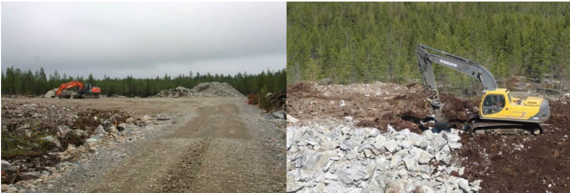
Kuva 4.13. Huoltoteiden ja pystytysalueiden rakentamista (kuvat: FCG).
