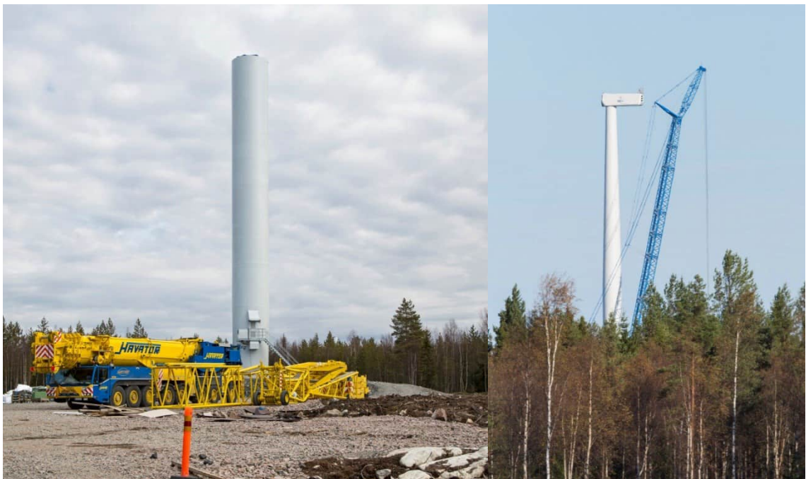
Kuva 4.17. Voimaloiden kokoamista (kuvat: FCG).
