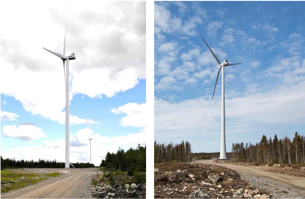
Kuva 4.2. Vasemmalla on esimerkki teräslieriötornista ja oikealla hybriditornista. (Kuvat: Leila Väyrynen, FCG)
