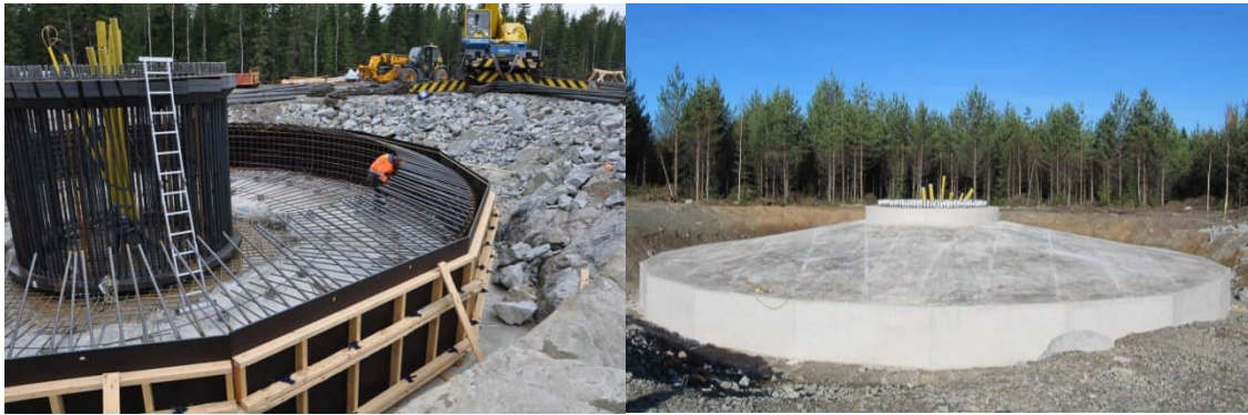
Kuva 4.15. Tuulivoimalan perustusten rakentamista (Kuvat: Leila Väyrynen, FCG).
