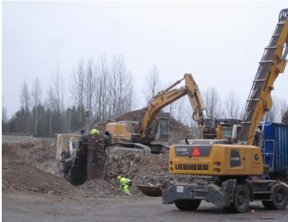
Kuva 34. Betonijätteen murskausta.
