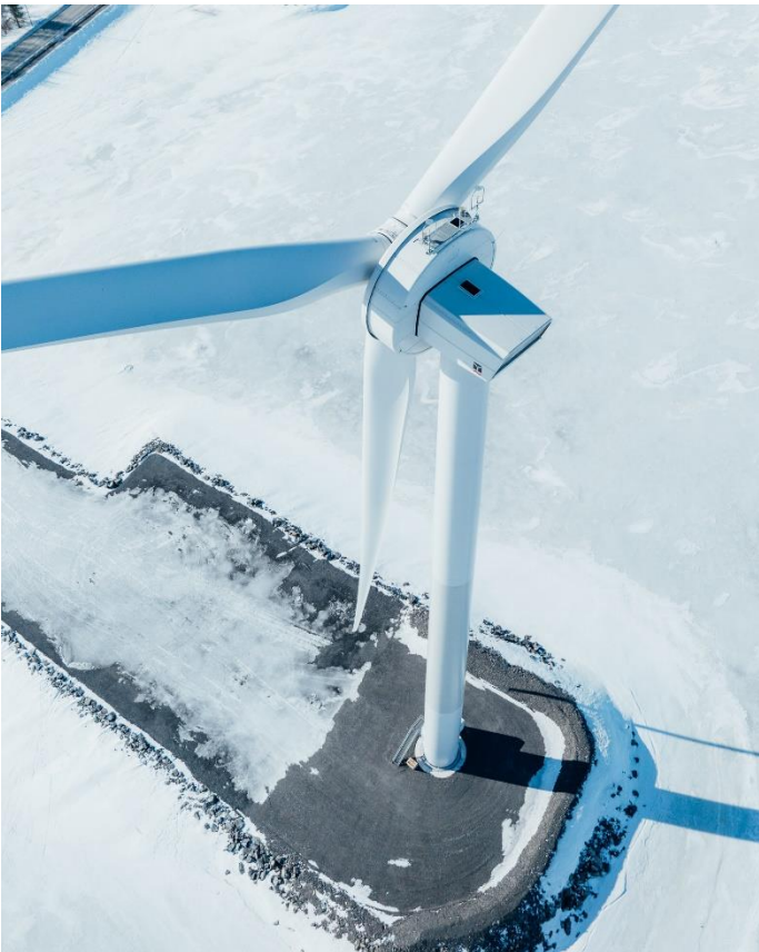
Kuva 9. Tuulivoimala perustuksineen (Solarwind Finland Oy).
