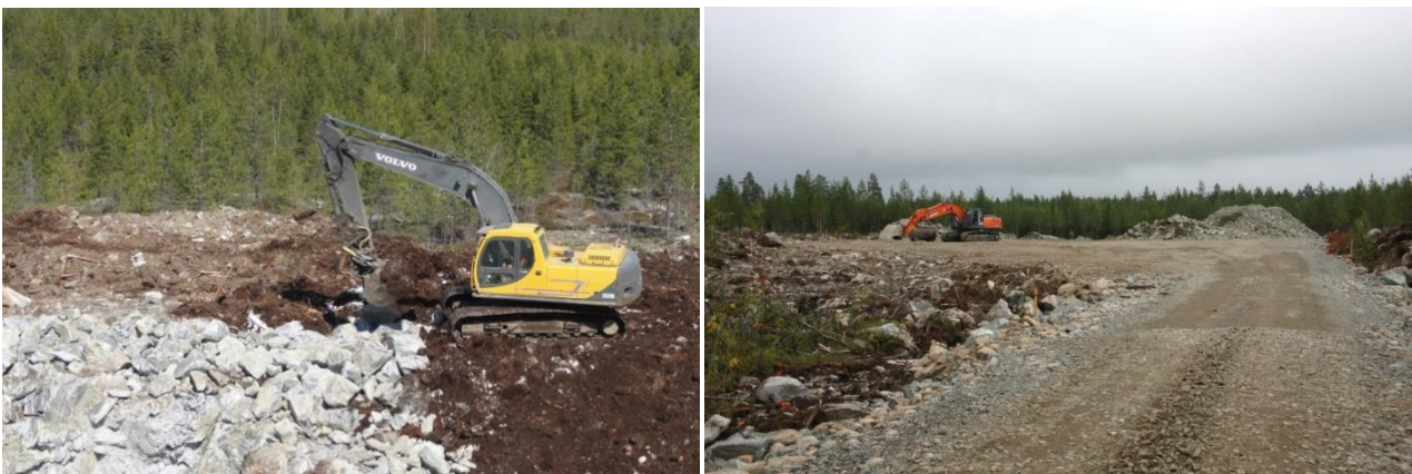
Kuvapari 5.10. Tuulivoimapuiston rakentaminen alkaa huoltoteiden ja pystytysalueiden rakentamisella (kuvat: FCG).
