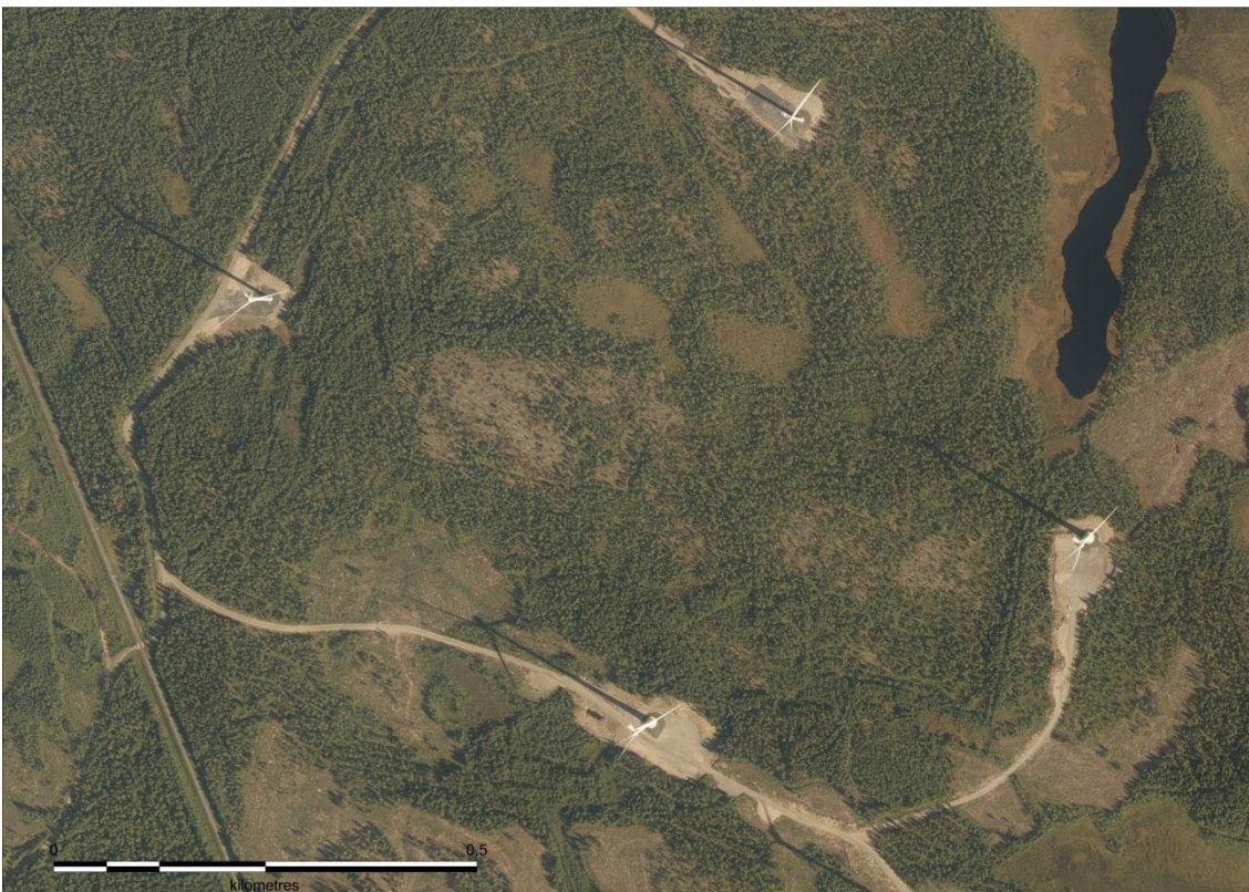
Kuva 5.1. Ilmakuvassa näkyy toiminnassa olevia tuulivoimaloita. Tuulivoimaloita varten on rakennettu huoltotiet ja nostokentät. Tuulivoimaloiden ympäristössä ja välialueilla aikaisempi maankäyttö on säilynyt ennallaan.
