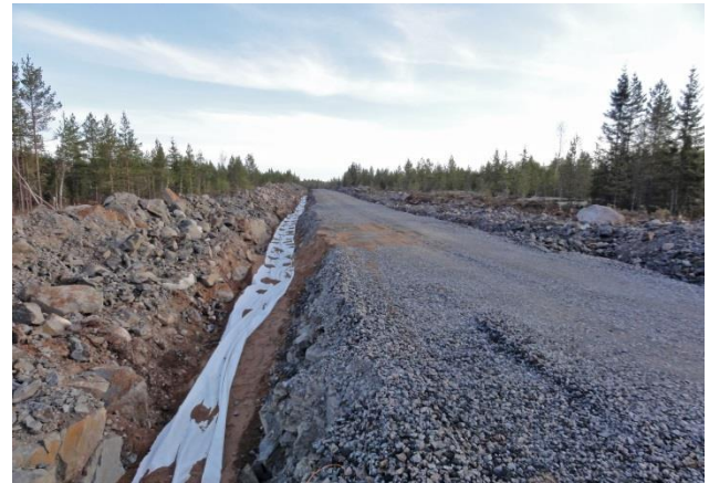
Kuvapari 5.11. Maakaapelit upotetaan huoltoteiden yhteyteen (kuvat: FCG).
