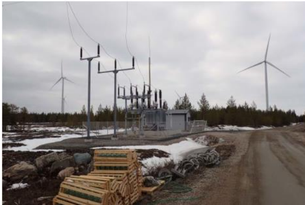
Kuva 5.15 Sähköaseman ja voimajohdon rakentamista. (Kuvat: FCG)
