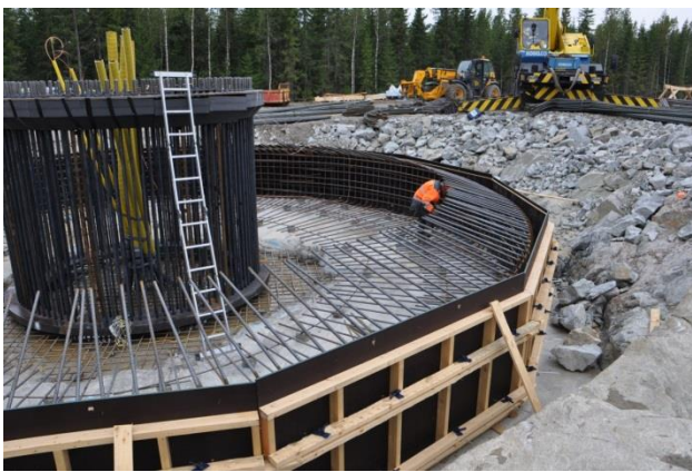
Kuvapari 5.12. Tuulivoimalan perustusten rakentamista. (Kuvat: FCG)
