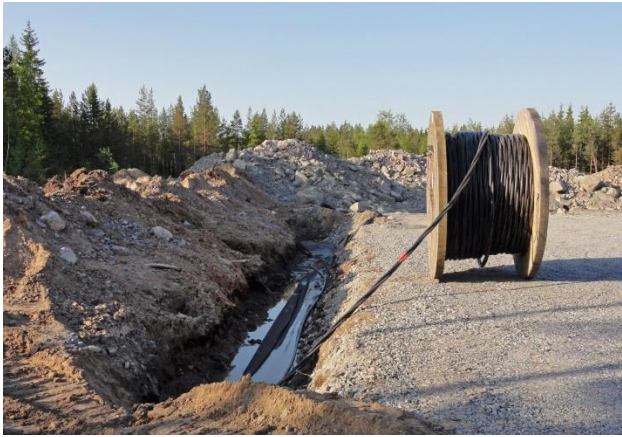
Kuvapari 5.11. Maakaapelit upotetaan huoltoteiden yhteyteen (kuvat: FCG).
