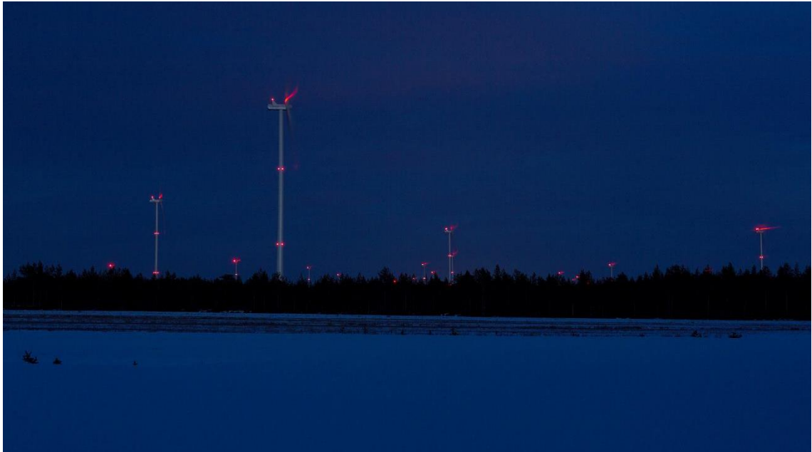
Kuva 5.4. Kiinteät punaiset lentoestevalot. (Kuva: FCG)
