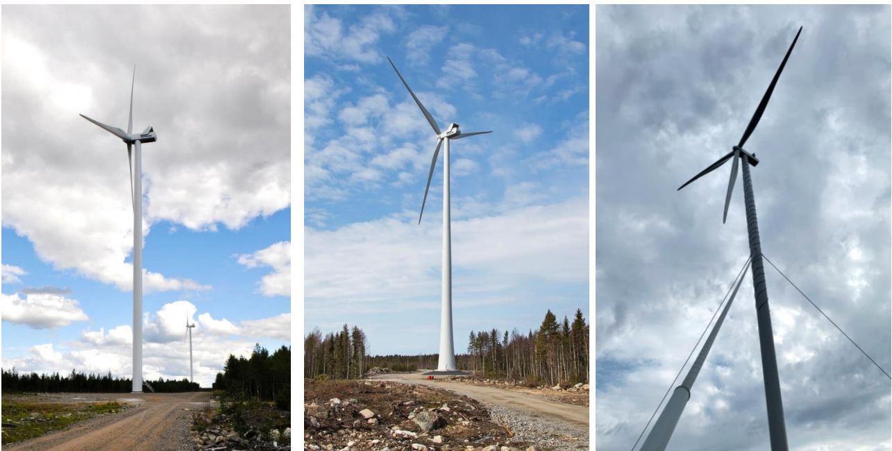
Kuva 5.2. Vasemmalla on esimerkki teräslieriötornista, keskellä hybriditornista ja oikealla harustusta tornista. (Kuvat: FCG sekä Jarkko Finnilä, Carelin)
