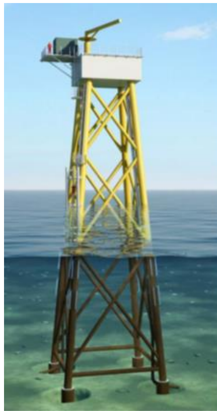
Figur 3.6. Typritning över fackverksfundament av typen Piled Jacked (källa: Ramboll)
