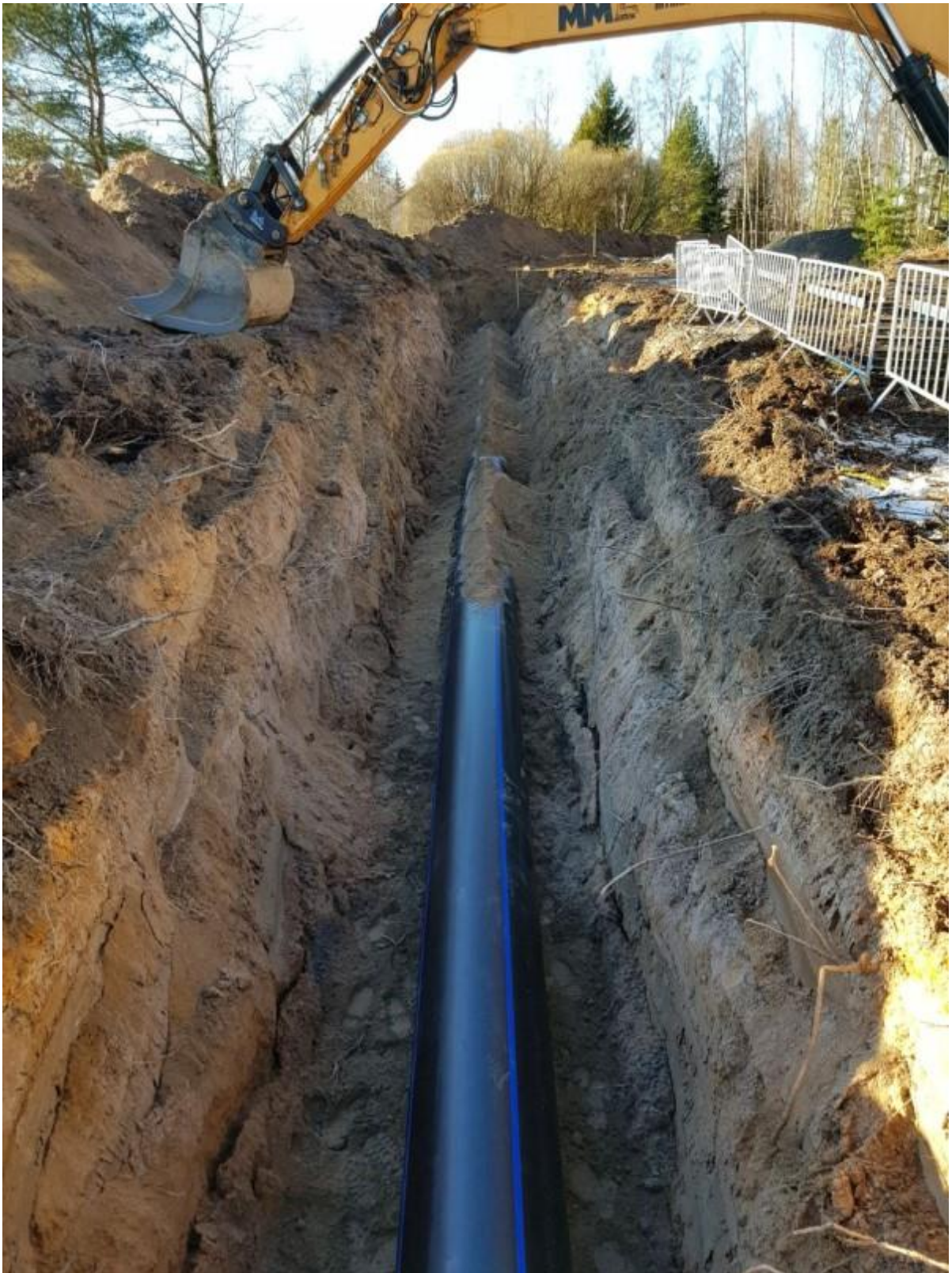
Kuva 6-4. Kuva putken upotuksesta.
