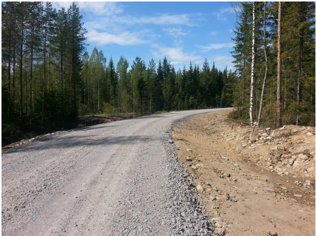
Kuva 2-9. Esimerkkikuva tuulivoimapuiston rakennus- ja huoltotiestä.
