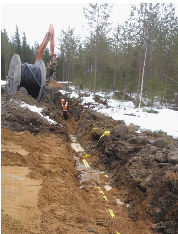
Kuva 2-8. Esimerkkikuva kaapeleiden sijoittamisesta kaapeliojaan.
