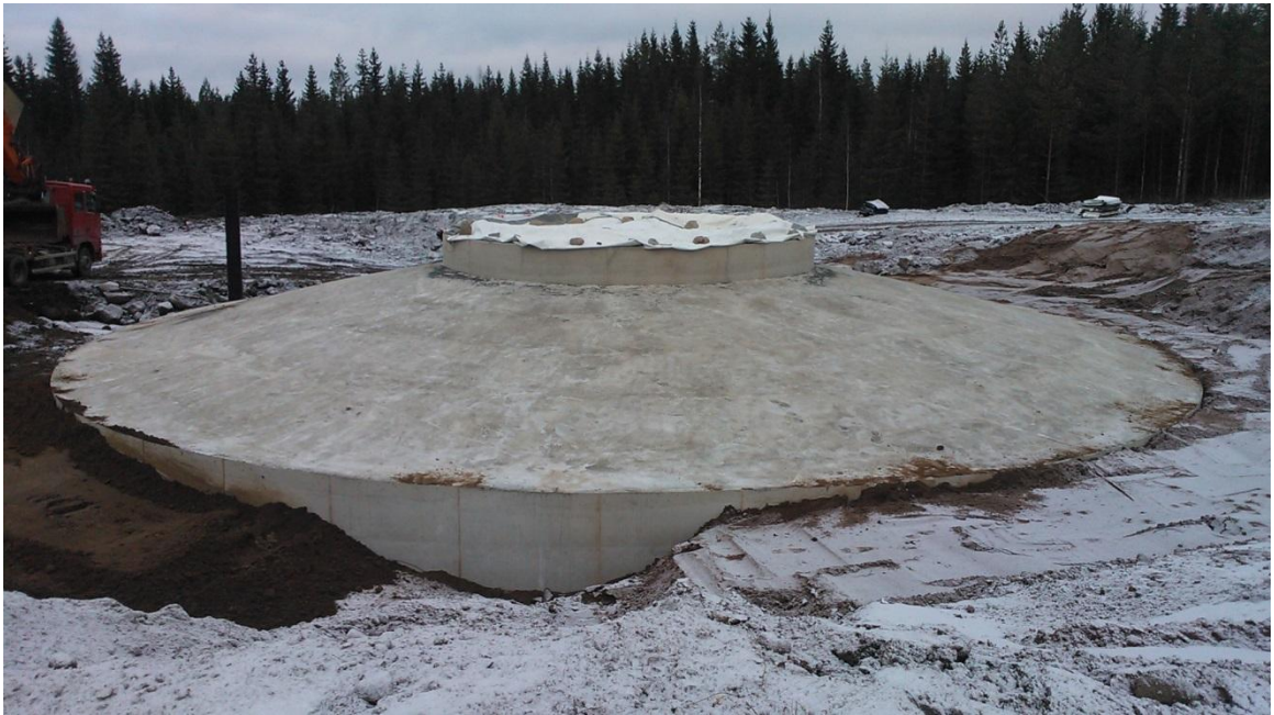
Kuva 2-10. Esimerkkikuva tuulivoimalan perustuksista.
