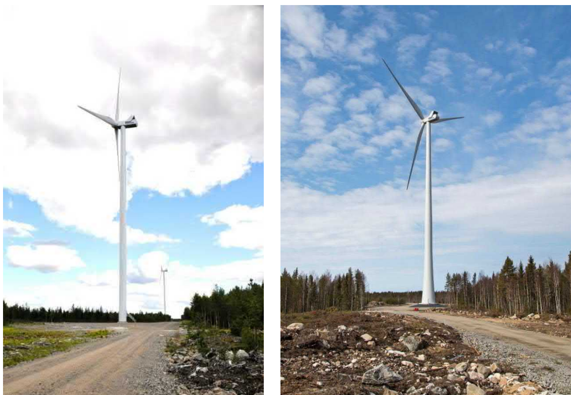
Bild 2.9. Till vänster ett exempel på ett cylindertorn och till höger ett hybridtorn. (Bilder: Leila Väyrynen och Ville Suorsa, FCG)
