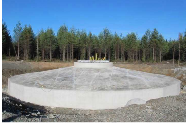
Bildpar 2.16. Byggande av vindkraftverkens fundament. (Bilder: Leila Väyrynen, FCG)
