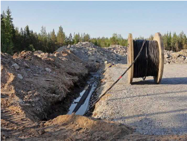
Bildpar 2.15. Jordkablarna grävs ner i anslutning till servicevägarna (bilder: Ville Suorsa/FCG).
