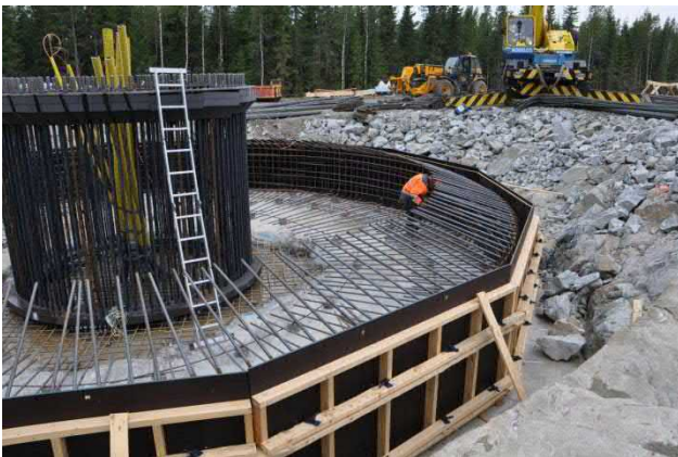
Bildpar 2.16. Byggande av vindkraftverkens fundament. (Bilder: Leila Väyrynen, FCG)
