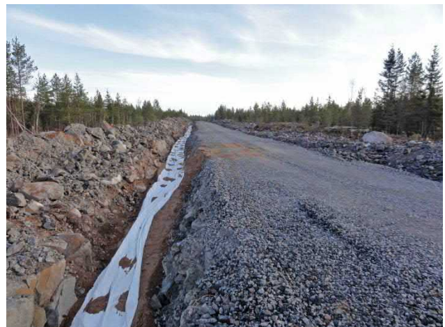
Bildpar 2.15. Jordkablarna grävs ner i anslutning till servicevägarna (bilder: Ville Suorsa/FCG).
