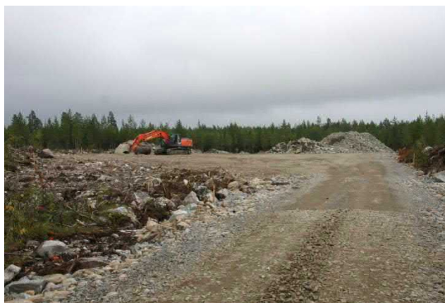
Bildpar 2.14. Byggnad av vindkraftsparken inleds med att bygga vägar och service-/resningsområden. (bilder: Ville Suorsa, FCG).
