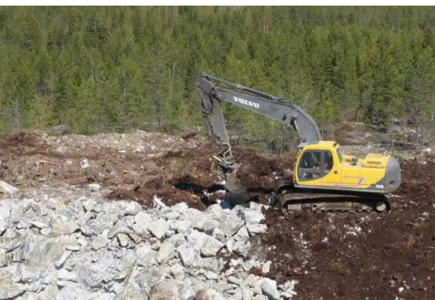
Bildpar 2.14. Byggnad av vindkraftsparken inleds med att bygga vägar och service-/resningsområden. (bilder: Ville Suorsa, FCG).
