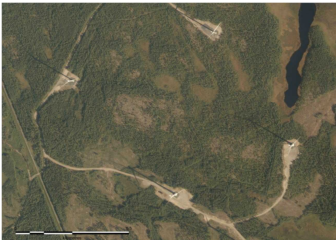
Bild 2.8. På flygbilden syns vindkraftverk som är i drift. Servicevägar och resningsfält har byggts för vindkraftverken. I omgivningen av vindkraftverken och mellan dem har den tidigare markanvändningen bevarats oförändrad.
