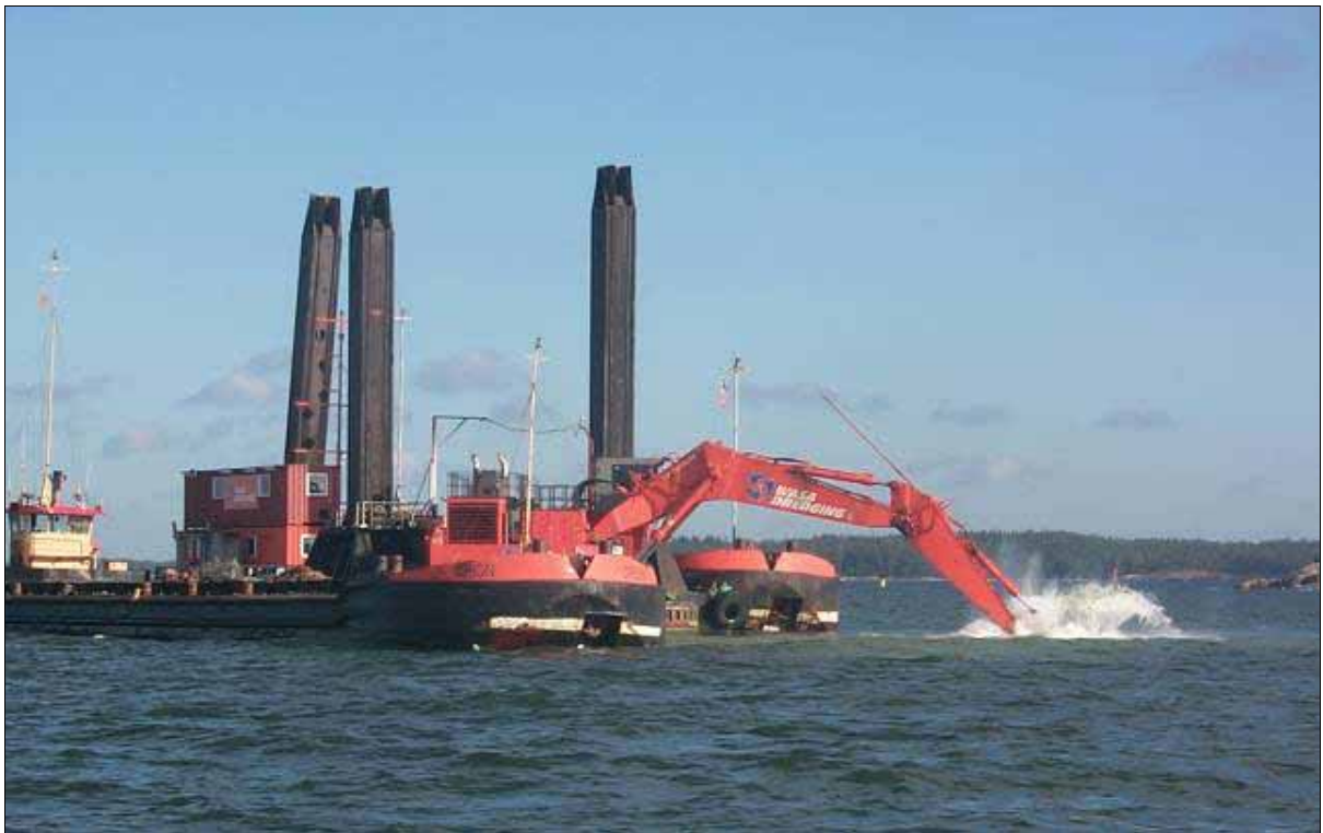
Kuva 2.2. Kuokkakauharuoppausta Vuosaaren satamassa. Ruoppaajan vieressä oleva proomu kuljettaa sedimenttimassat läjitysalueelle.
