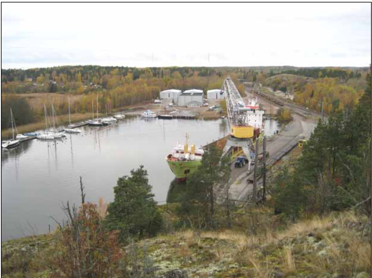
Kuva 2.1. Pohjanpitäjänlahden pohjukassa sijaitseva Pohjankurun satama. Satamalta ruopataan suunnitelman mukaan 17 000 m 3 ktr, joista osa läjitetään maalle.
