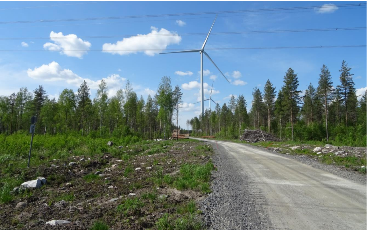
Kuva 16. Esimerkki tuulivoimapuiston rakennus- ja huoltotiestä. Maakaapelin oja on sijoitettu tien vasemmalle puolelle (Kuva: Sweco Finland Oy).
