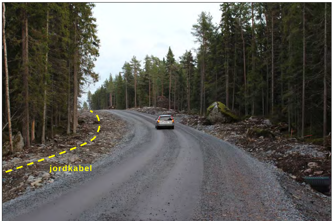
Figur 3.5. Exempel på bygg- och serviceväg för vindkraftsparken. Vägarna används bland annat för transport av betong och grus samt kraftverkens komponenter. I driftskedet används vägarna bl.a. för årlig service. Diket för jordkabeln finns på vägens vänstra sida (foto: Hans Vadbäck/FCG).
