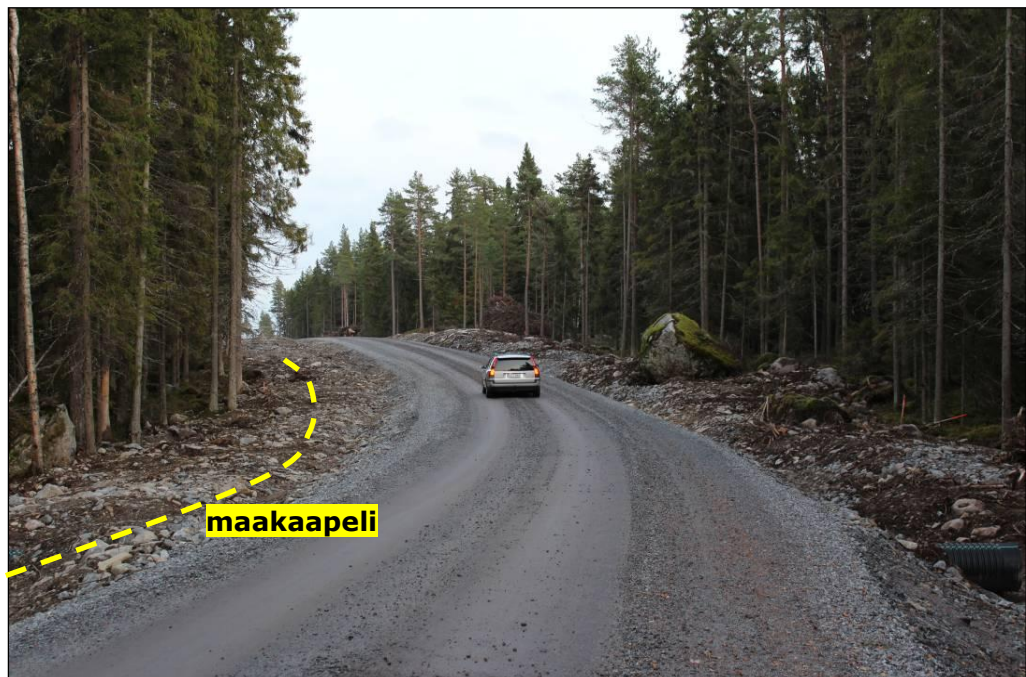
Kuva 11. Esimerkkikuva tuulipuiston huoltotiestä sekä sen yhteyteen sijoitetusta sähkönsiirtokaapelista.
