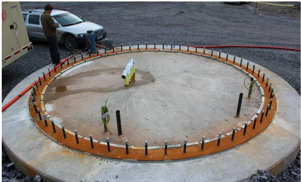
Kuva 7. Esimerkki tuulivoimalan perustuksesta, jonka halkaisija noin 6 metriä.
