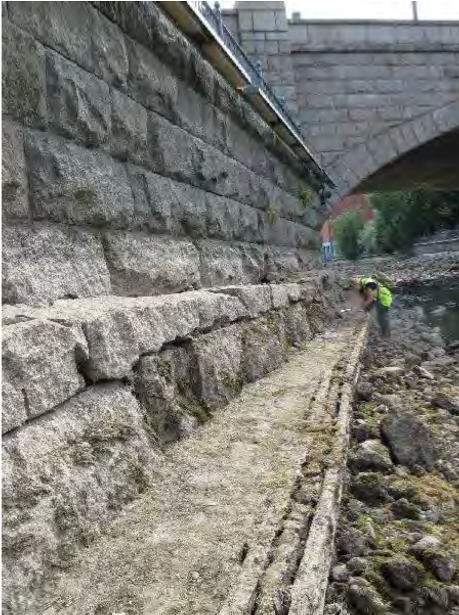
Hämeensillan itäpään ja rantapenkan kulman puiset ja kiviset tukirakenteet pohjoisesta kohde 10 b. Hannele Kuitunen
