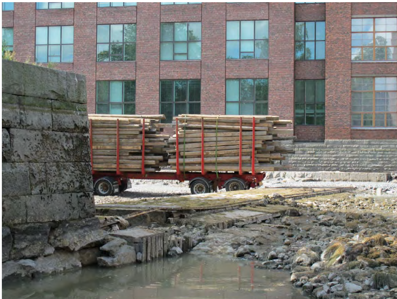
Konsulinsaaren pohjoispään kanavarakenteen kansi. Hannele Kuitunen
