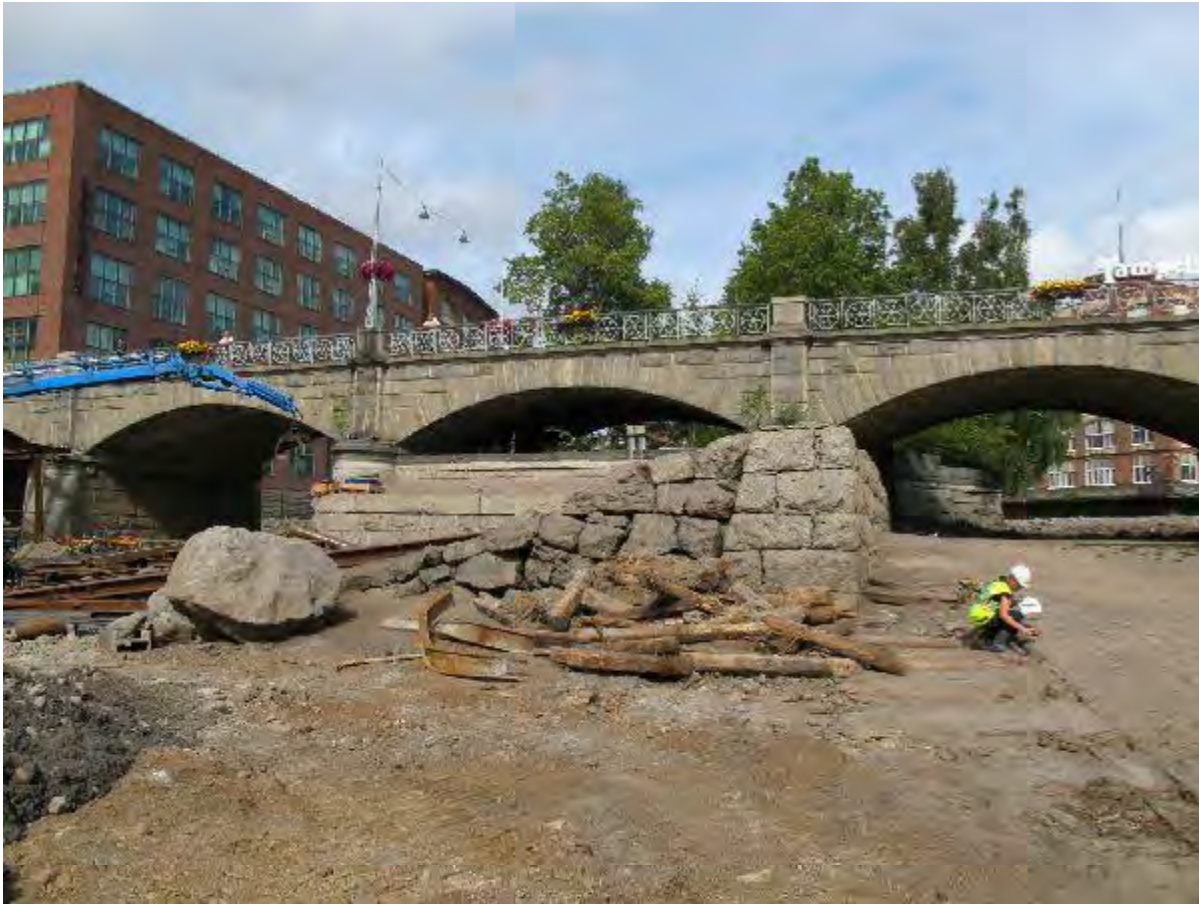
Kivirakenne Satakunnan sillan eteläkylki etelästä. Hannele Kuitunen
