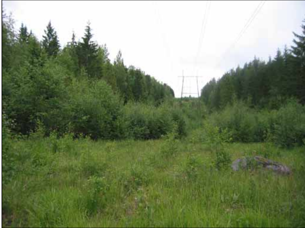
Kuva 7-35. Pirkkalan sijoituspaikan eteläpuolella kulkeva voimajohto.
