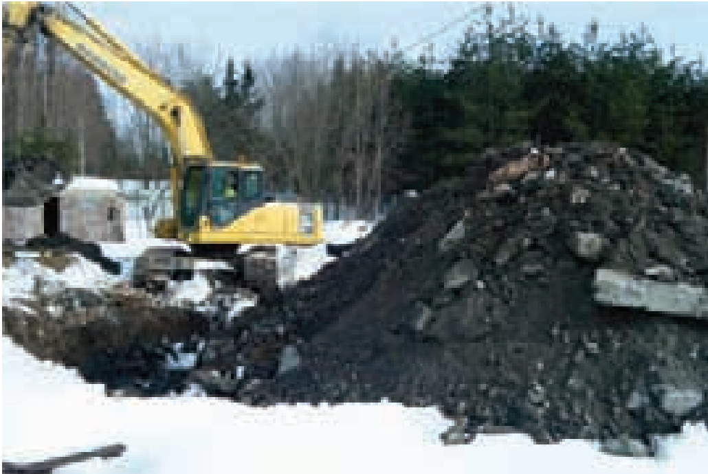
Kuva 1. Koekuopan KK5 kaivua entisellä kaatopaikalla 1.3.2012
