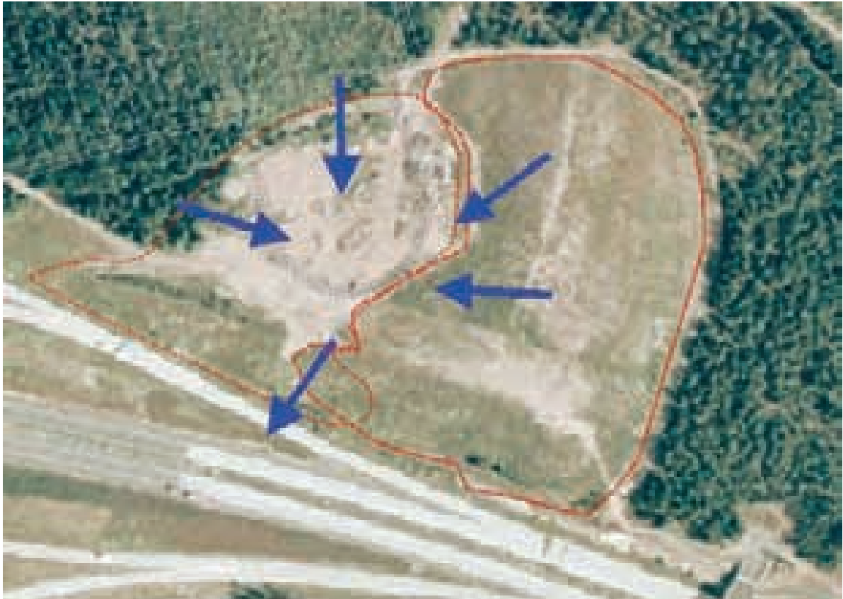
Kuva 2. Pohjavesien arvioitu virtaussuunta alueella. Pohjavedet ja täytön sisäiset vedet purkautuvat ohitustien penkasta pintavedeksi. Ilmakuva 1995, Copyright Blom-kartta Oy 1996.
