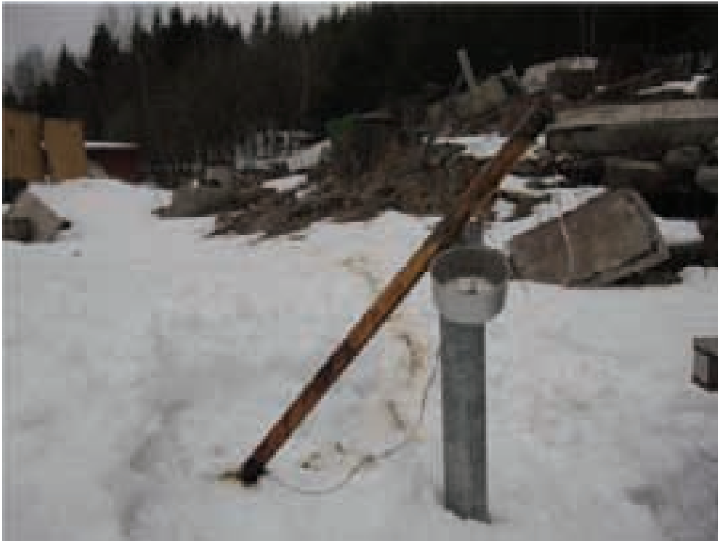
Kuva 3. Öljyistä täytön sisäistä vettä pohjavesiputkessa PE3 11.4.2012
