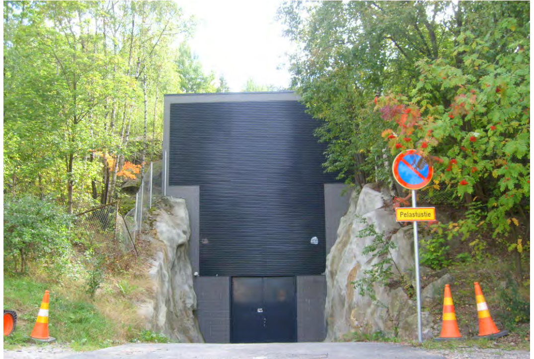
Kuva 13. Esimerkkikuva ajotunnelin suuaukon rakenteista. (Kakolanmäen kalliopuhdistamon ajotunneli, Turku. Kuva: FCG Finnish Consulting Group Oy:n arkisto).
