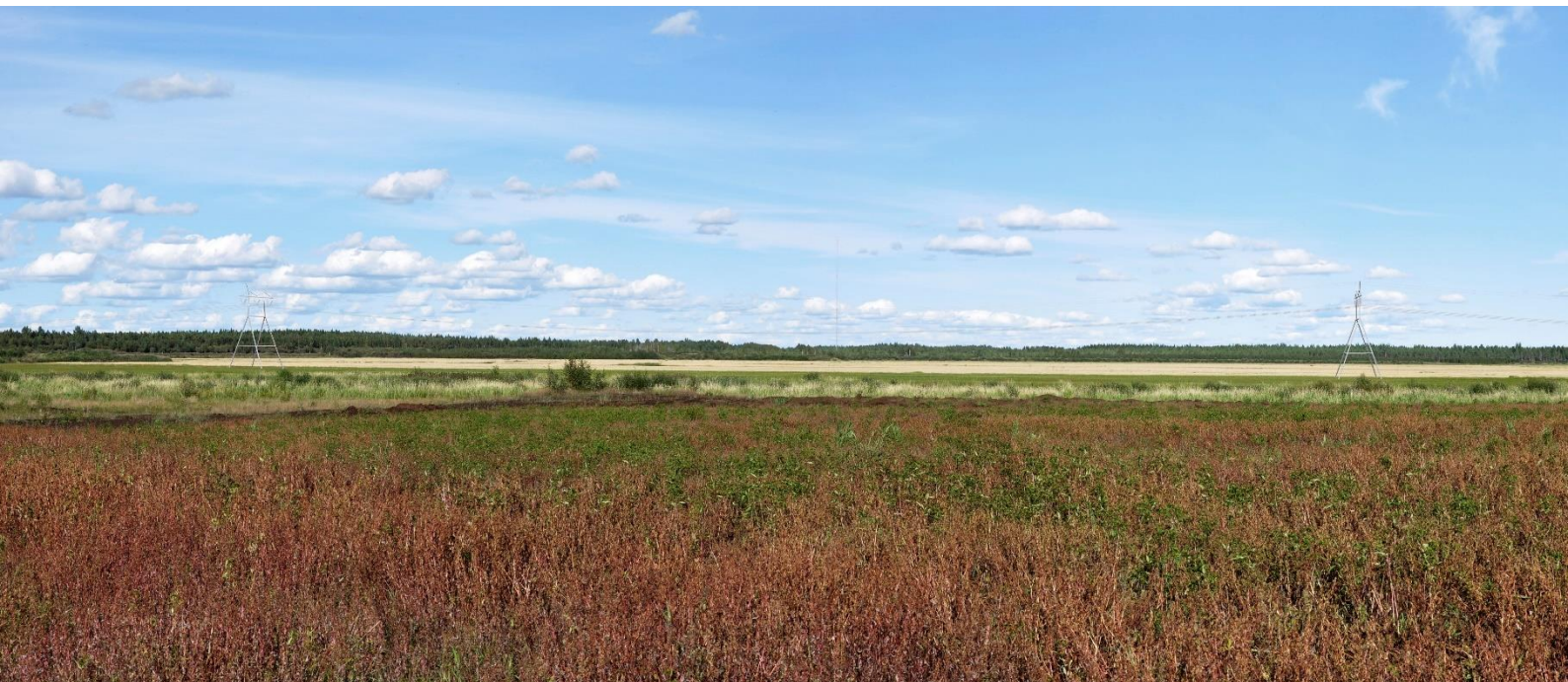
Kuva 35. Havainnekuva 2. Piipsannevalta, kuvaussuunta itään. Voimajohto sijoittuu peltoalueiden väliin. Kuvaan on mallinnettu 400 kV voimajohto vapaasti seisovilla peltopylväillä. Kuvan keskellä taustamaisemassa näkyy tuulimittausmasto, jonka korkeus on 120 metriä.
