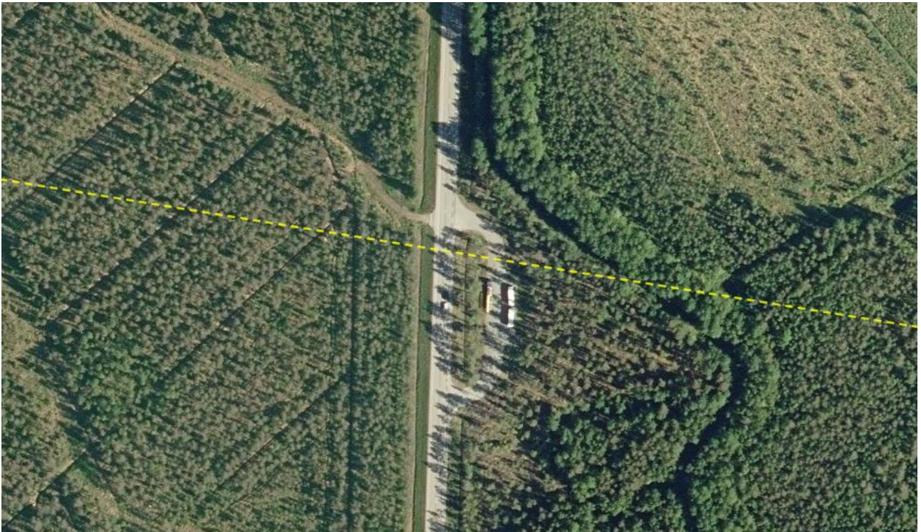
Kuva 60. Nelostien eteläisempi ylityskohta.
