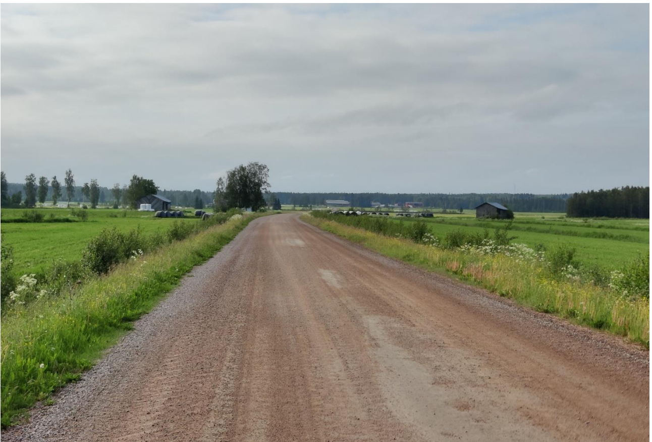
Kuva 31. Voimajohtoreitti ylittää Turvetien Pitkäperän ja Rautionnevan välisellä osuudella. Taustalla Leppiojanperän rakennuskantaa, johon etäisyyttä sähkölinjan ylityskohdalta noin 1,5 kilometriä (nykytila).
