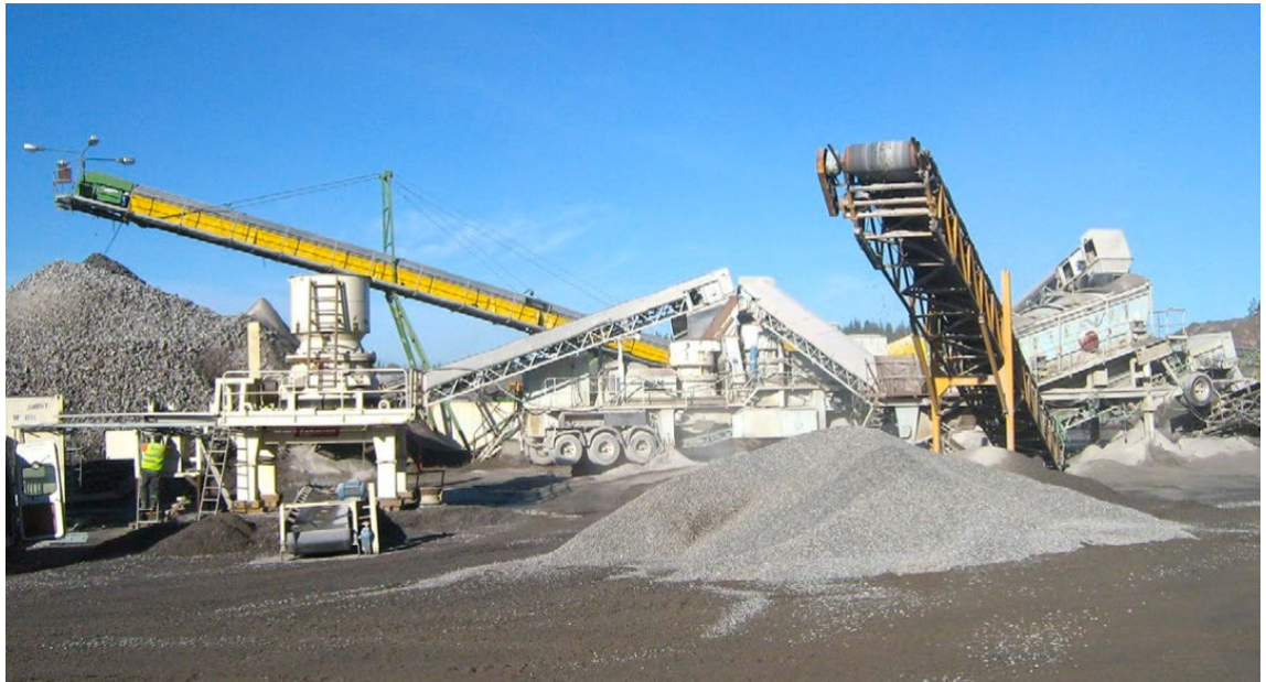
Kuva 3-6. Esimerkki kivenmurskaamosta. Kuva ©: Ympäristöministeriö 2020 / Jari Rintala.
