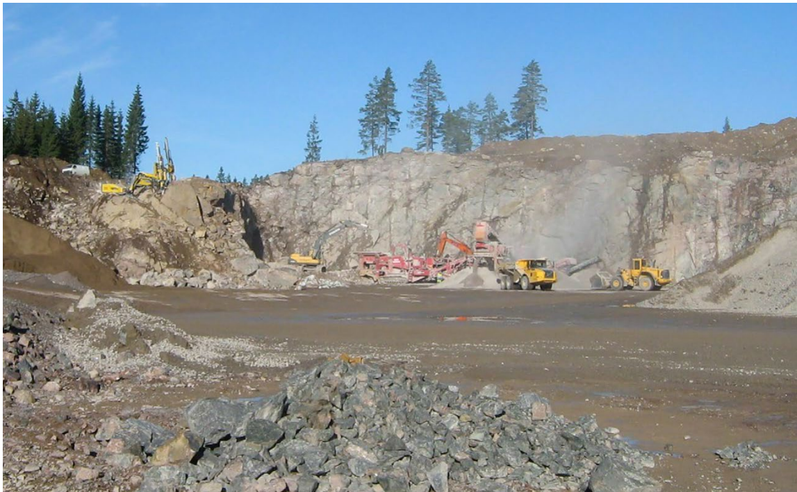
Kuva 3-5. Esimerkki kiviainesoittoalueen toiminnasta. Kuvassa vasemmalla porausta, keskellä murskausta, oikealla kuljetusta ja varastointia. Kuva ©: Ympäristöministeriö 2020 / Jari Rintala.
