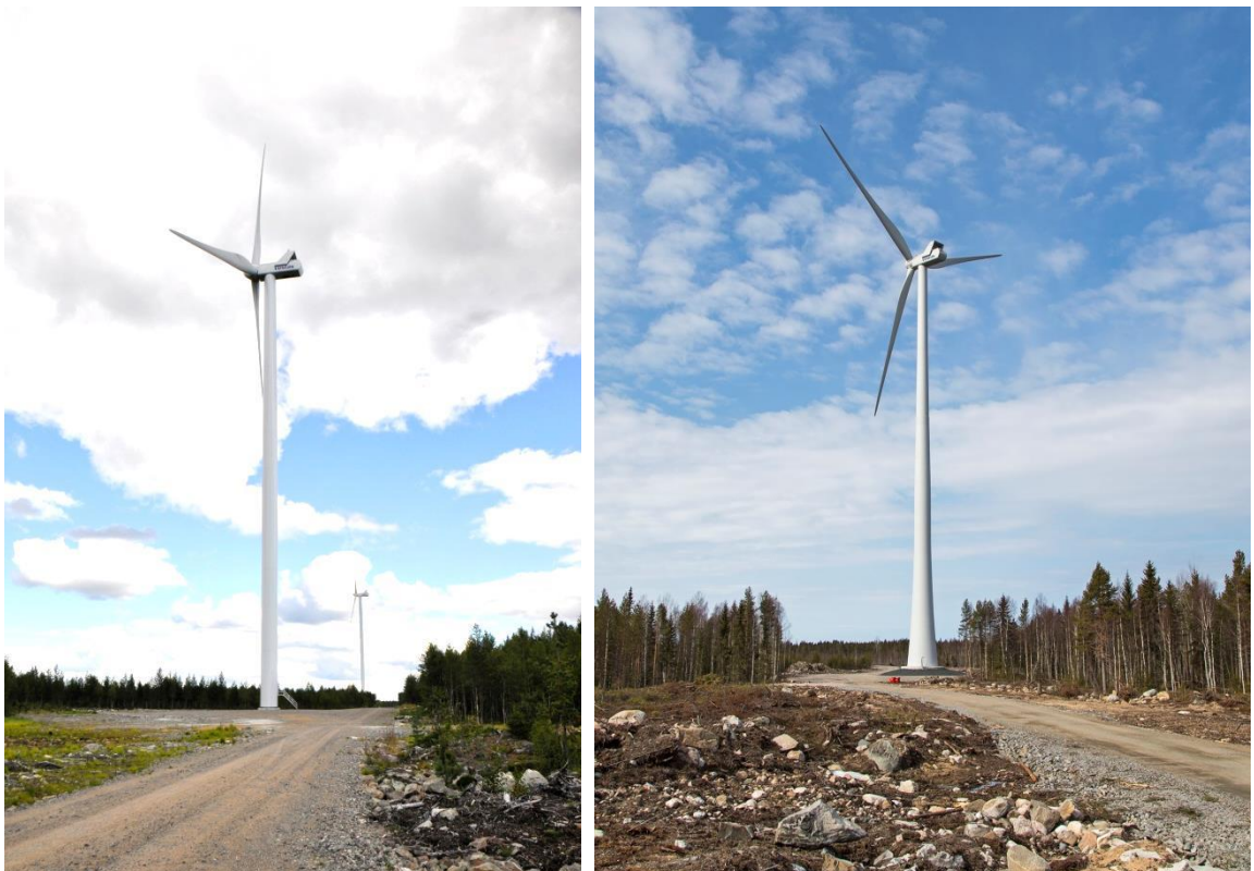
Kuva 5.2. Vasemmalla on esimerkki teräslieriötornista ja oikealla hybriditornista. (Kuvat: Leila Väyrynen ja Ville Suorsa, FCG)
