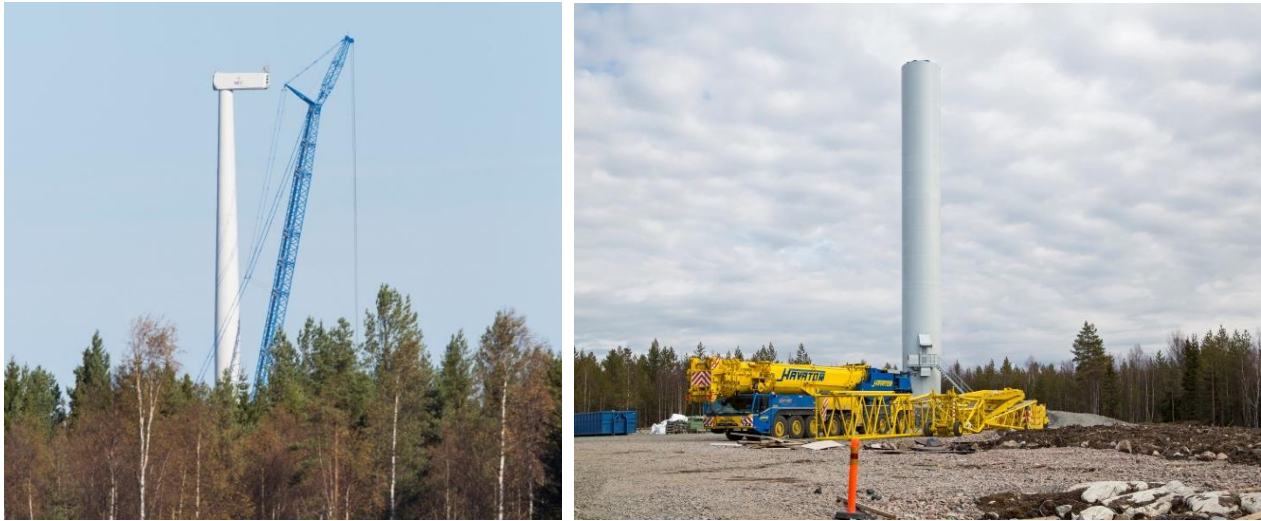
Kuvapari 5.13. Tuulivoimalan kokoamista. (Kuvat: Ville Suorsa, FCG)
