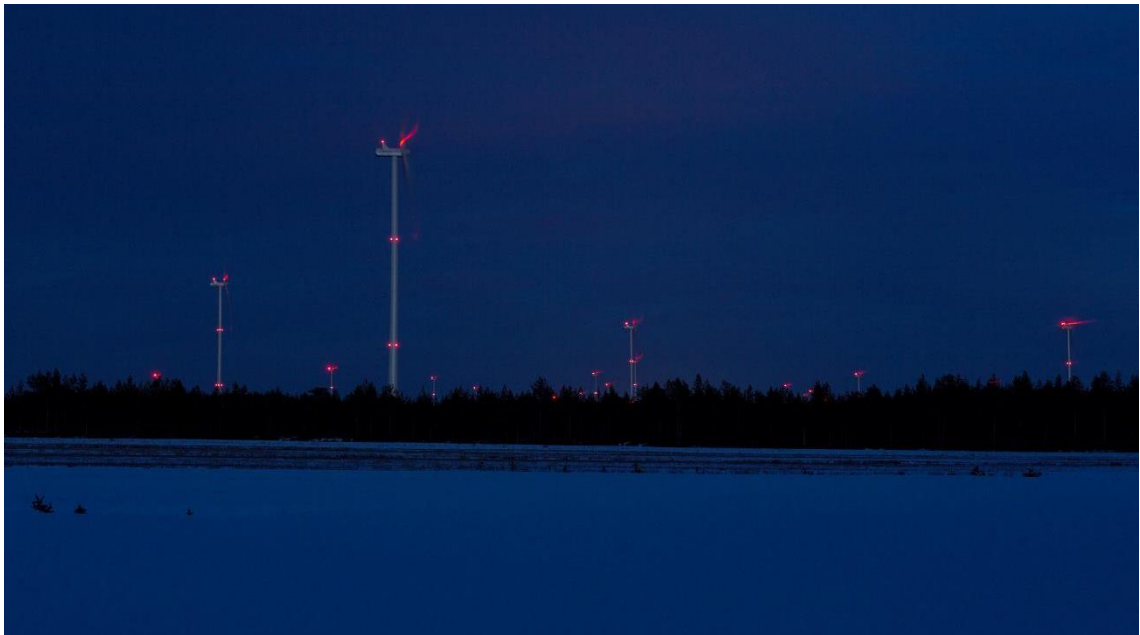
Kuva 5.4. Kiinteät punaiset lentoestevalot. (Kuva: Ville Suorsa, FCG)
