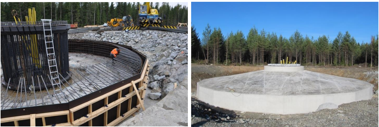
Kuvapari 5.11. Tuulivoimalan perustusten rakentamista. (Kuvat: Leila Väyrynen, FCG)
