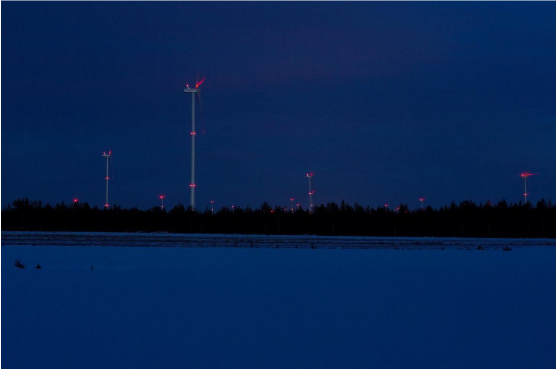
Kuva 4.4. Kiinteät punaiset lentoestevalot. (Kuva: Ville Suorsa, FCG)
