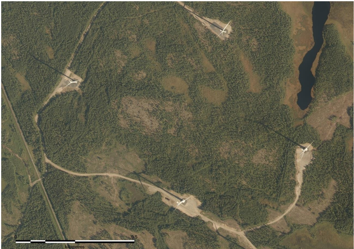
Kuva 4.1. Ilmakuvasa näkyy toiminnassa olevia tuulivoimaloita. Tuulivoimaloita varten on rakennettu huoltotiet ja nostokentät. Tuulivoimaloiden ympäristössä ja välialueilla aikaisempi maankäyttö on säilynyt ennallaan.
