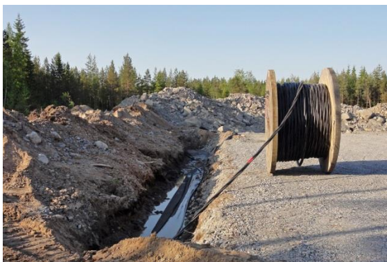
Kuvapari 4.13. Maakaapelit upotetaan huoltoteiden yhteyteen (kuvat: Ville Suorsa/FCG).
