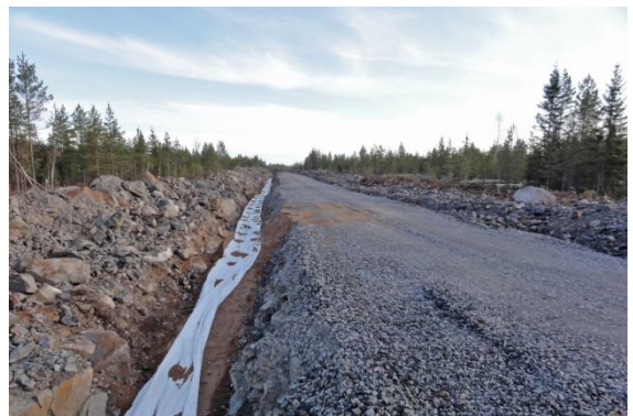
Kuvapari 4.13. Maakaapelit upotetaan huoltoteiden yhteyteen (kuvat: Ville Suorsa/FCG).
