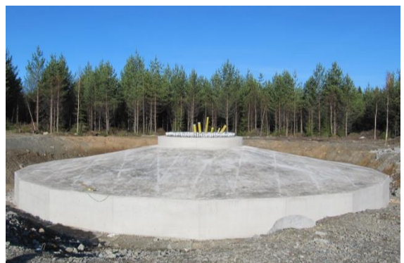
Kuvapari 4.14. Tuulivoimalan perustusten rakentamista. (Kuvat: Leila Väyrynen, FCG)
