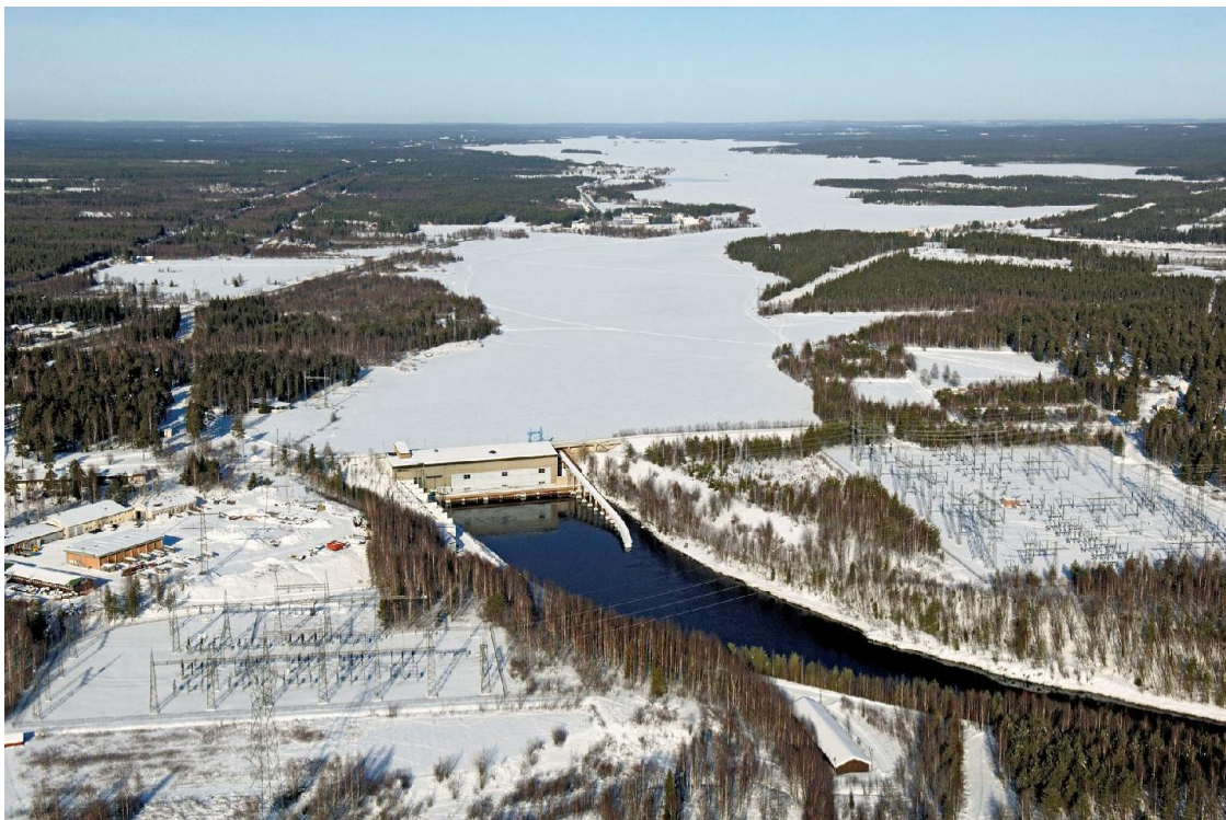
Kuva 5-1. Viistoilmakuva etelän suunnasta: Petäjäskosken voimalaitos ja sitä ympäröiviä sähköntuotantoon ja -siirtoon liittyviä rakenteita. Kuvälähde: Kemijoki Oy.
