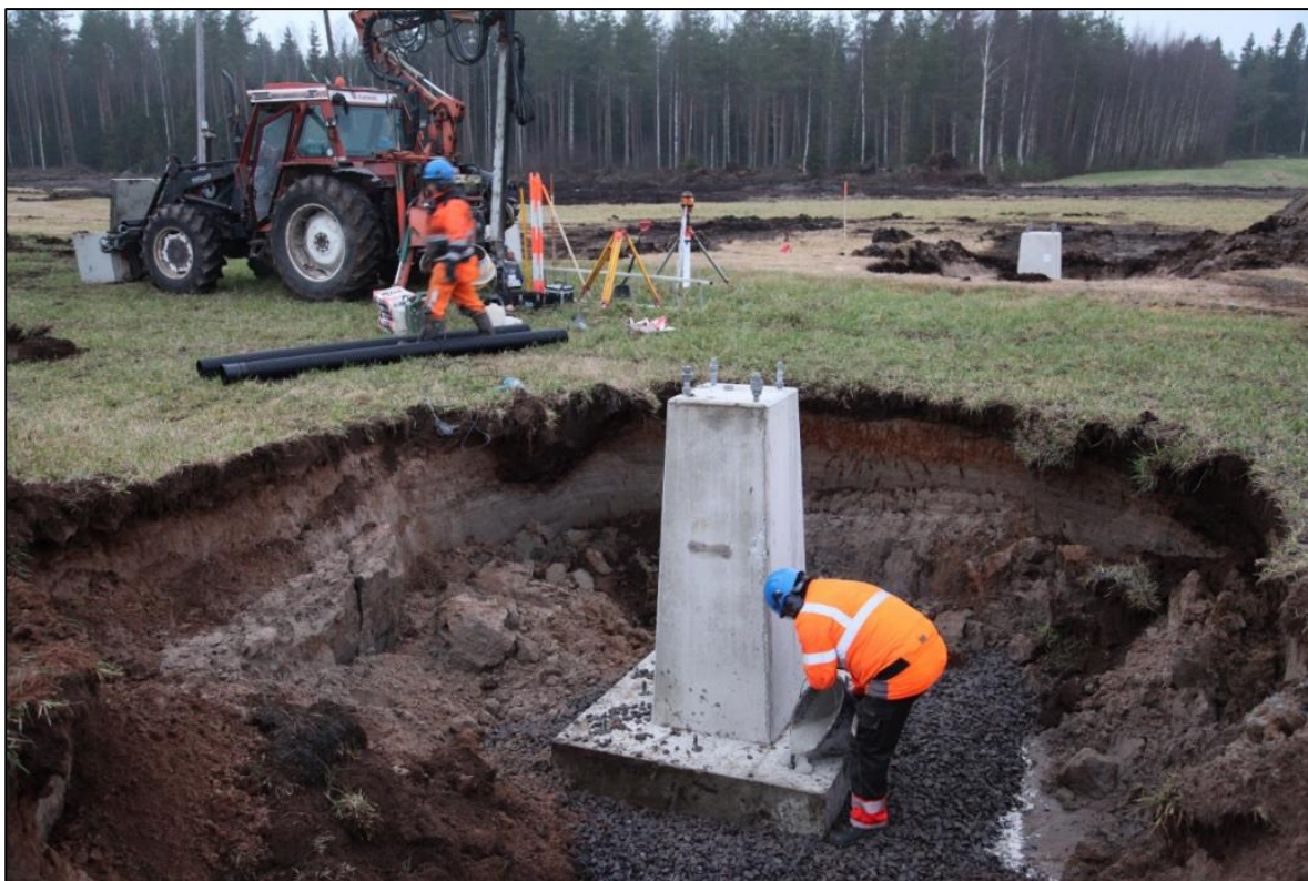
Kuva 7. Pylvään perustuselementin asentaminen.
