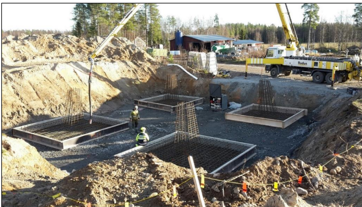
Kuva 8. Vapaasti seisovan pylvään perustustöitä.
