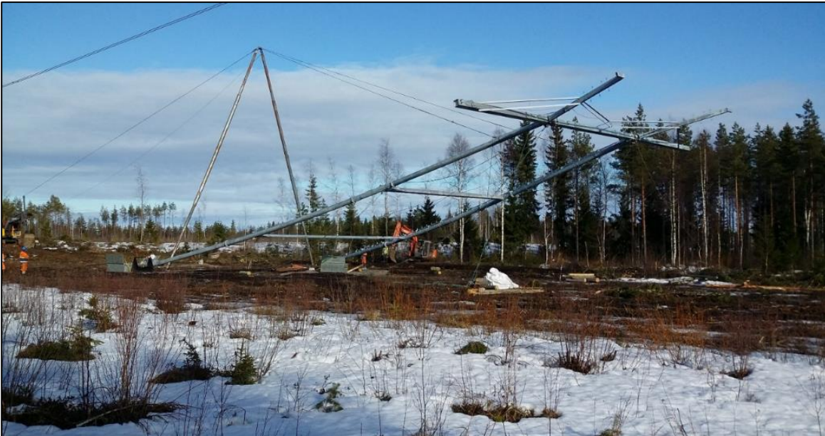
Kuva 9 Voimajohtopylvään pystytys.
