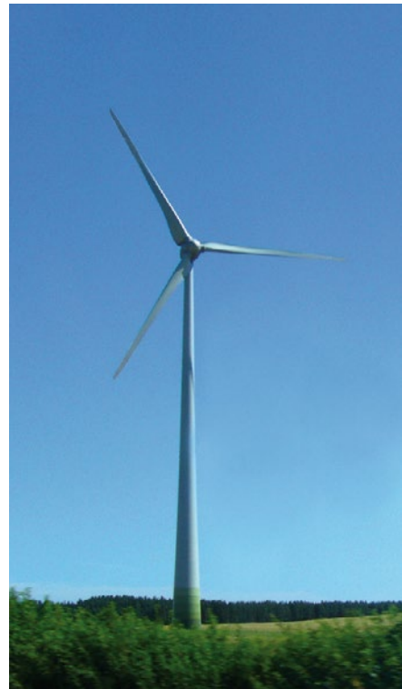
Kuva 3-2. Kuva lieriötornirakenteisesta tuulivoimalasta.
