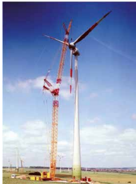
Kuva 3-16. Tuulivoimalan pystytys (Liebherr).
