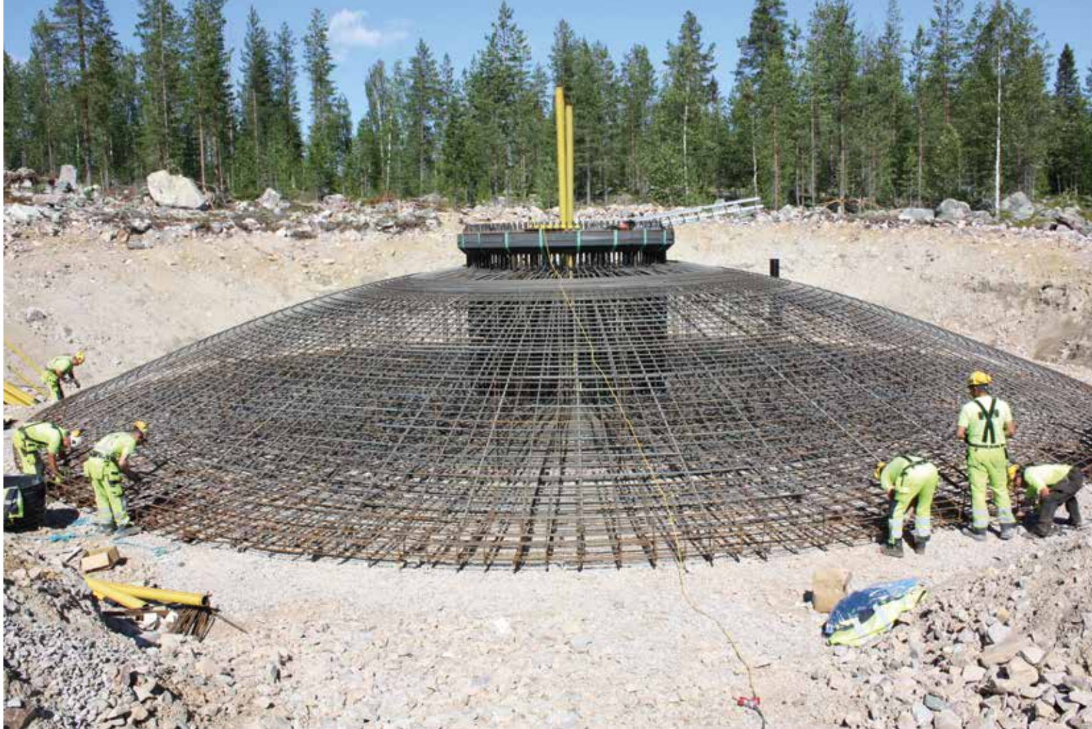
Kuva 3-8. Maanvarainen teräsbetoniperustus raudoitettuna ennen betonivalua, Tervola.
