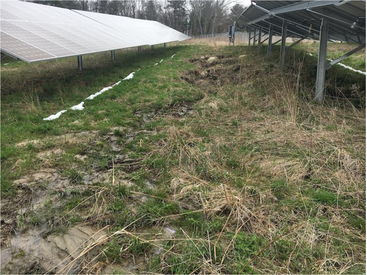
Kuva 120. Eroosiohaittoja paneelien välissä. Kuva ei ole Honkahuhdan hankkeesta (kuva: https://www.stormwater.com/home/article/21148549/solar-and-stormwater ).
