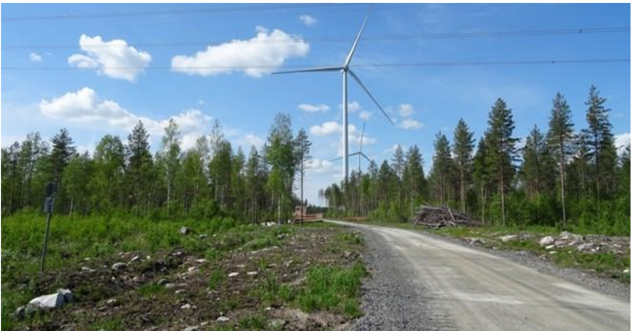
Kuva 18. Esimerkki tuulivoima-alueen rakennus- ja huoltotiestä. Maakaapelin oja on sijoitettu tien vasemmalle puolelle. Teitä käytetään muun muassa betonin ja soran sekä voimaloiden komponenttien kuljetuksiin. Käyttövaiheessa teitä käytetään mm. vuosittaisissa huolloissa.
