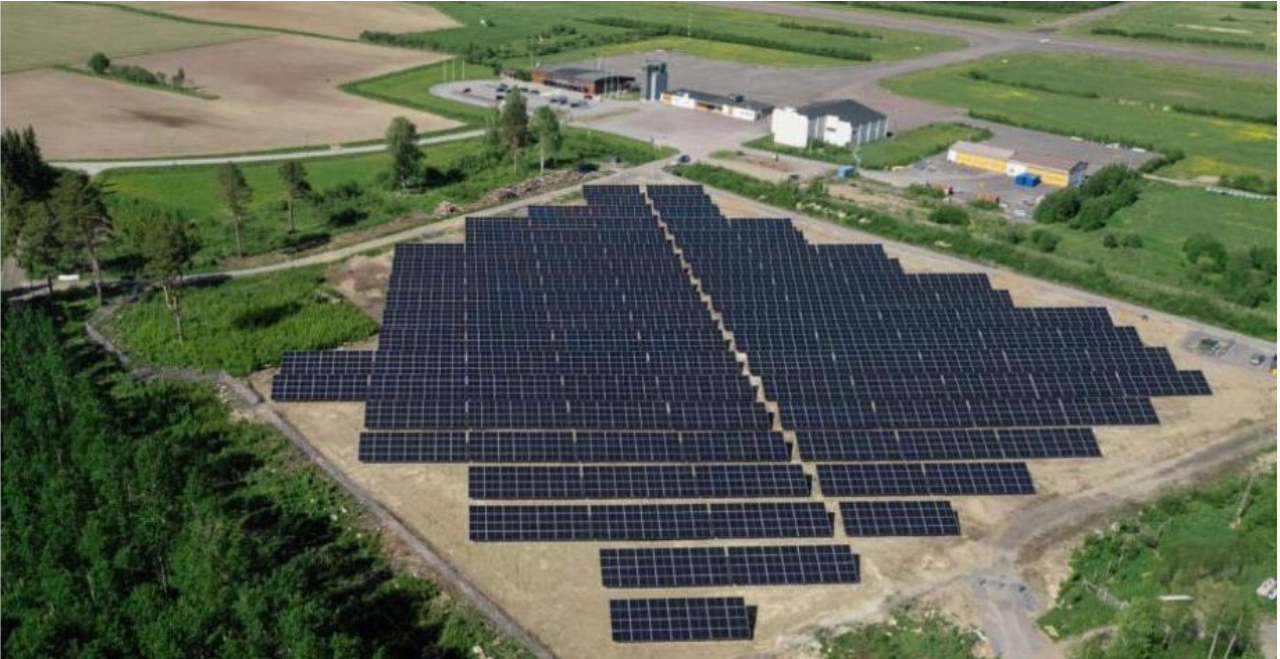
Kuva 16. Esimerkkikuva aurinkovoimalasta. Kuvassa Joroisten lentokentän alueen aurinkovoimapuisto (Kuva: Ilmatar Energy Oy).
