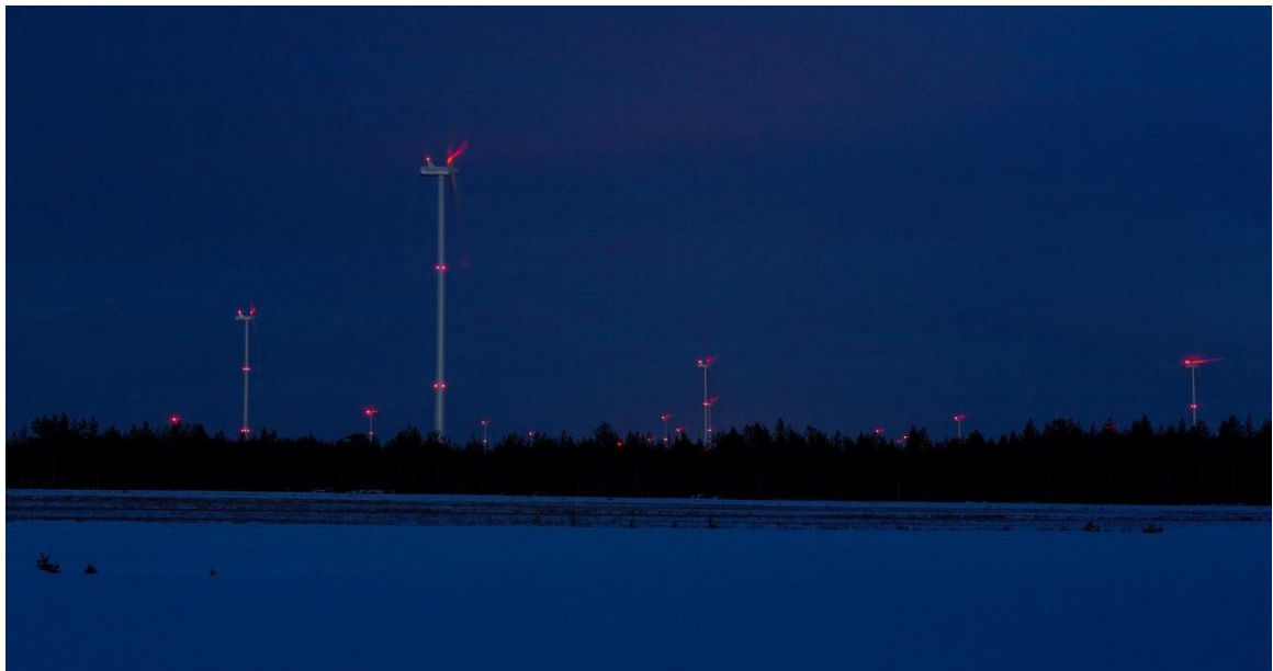
Kuva 12. Kiinteät punaiset lentoestevalot (Kuva: FCG).
