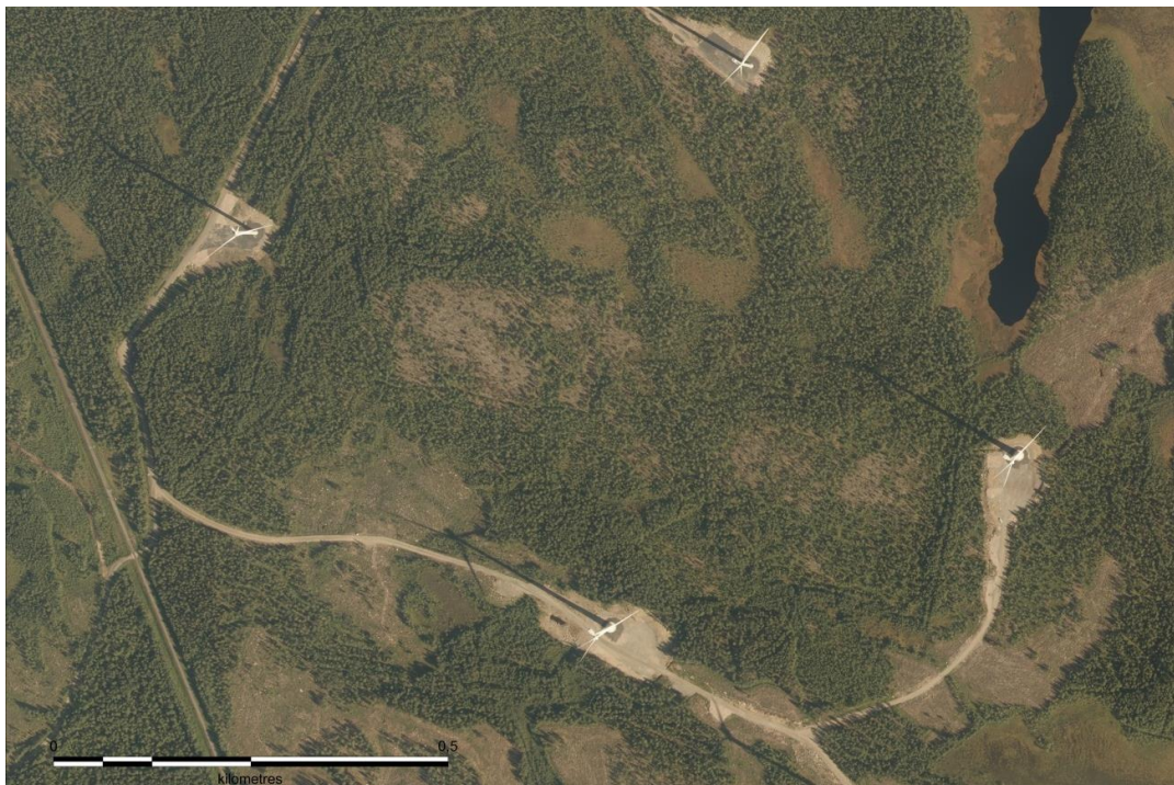
Kuva 9. Ilmakuvassa näkyy toiminnassa olevia tuulivoimaloita. Tuulivoimaloita varten on rakennettu huoltotiet ja nostokentät. Tuulivoimaloiden ympäristössä ja välialueilla aikaisempi maankäyttö on säilynyt ennallaan.
