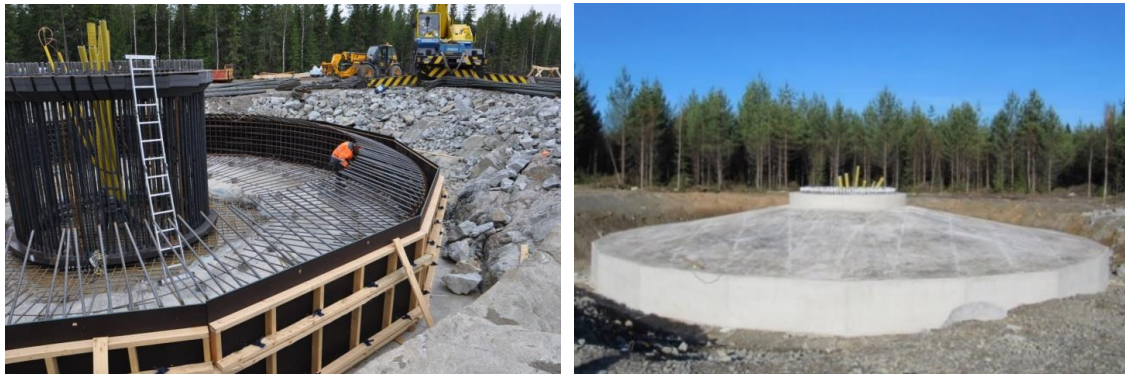
Kuva 18. Tuulivoimalan perustusten rakentamista (kuvat: Leila Väyrynen, FCG).
