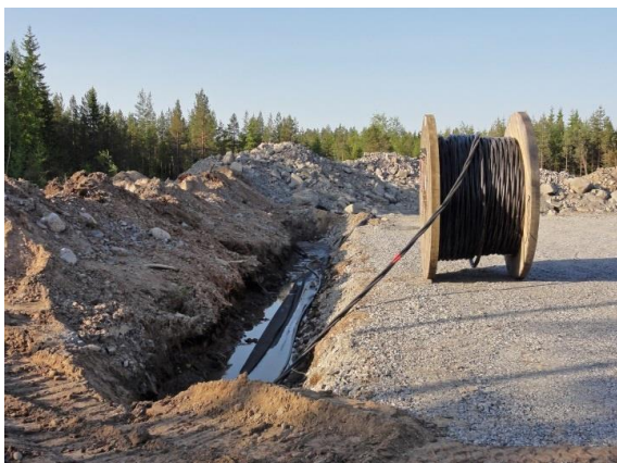
Kuva 17. Maakaapelit upotetaan huoltoteiden yhteyteen (kuvat: FCG).
