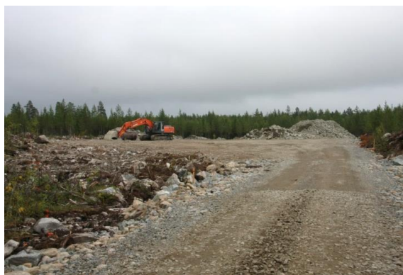
Kuva 16. Tuulivoimapuiston rakentaminen alkaa huoltoteiden ja pystytysalueiden rakentamisella (kuvat: FCG).
