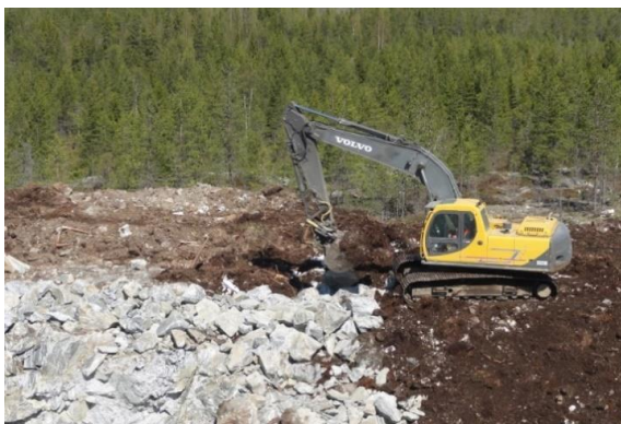
Kuva 16. Tuulivoimapuiston rakentaminen alkaa huoltoteiden ja pystytysalueiden rakentamisella (kuvat: FCG).
