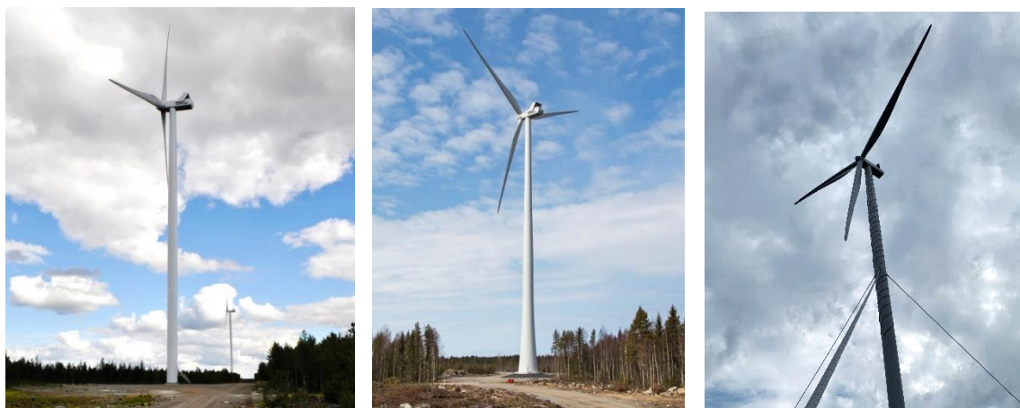
Kuva 10. Vasemmalla on esimerkki teräslieriötornista, keskellä hybriditornista ja oikealla harustetusta tornista. (Kuvat: FCG sekä Jarkko Finnilä, Carelin)
