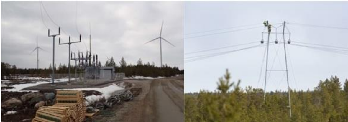
Kuva 21. Sähkösäntan ja voimajohdon rakentamista (kuvat: FCG).
