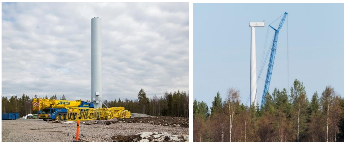
Kuva 19. Tuulivoimalan kokoamista (kuvat: FCG).
