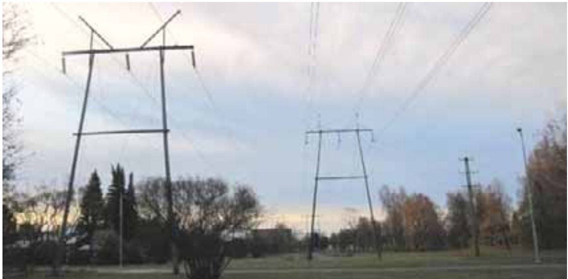
Kuva 10-23. Voimajohdot ovat osa maisemaa ennen Isosannan sähköasemaa.
