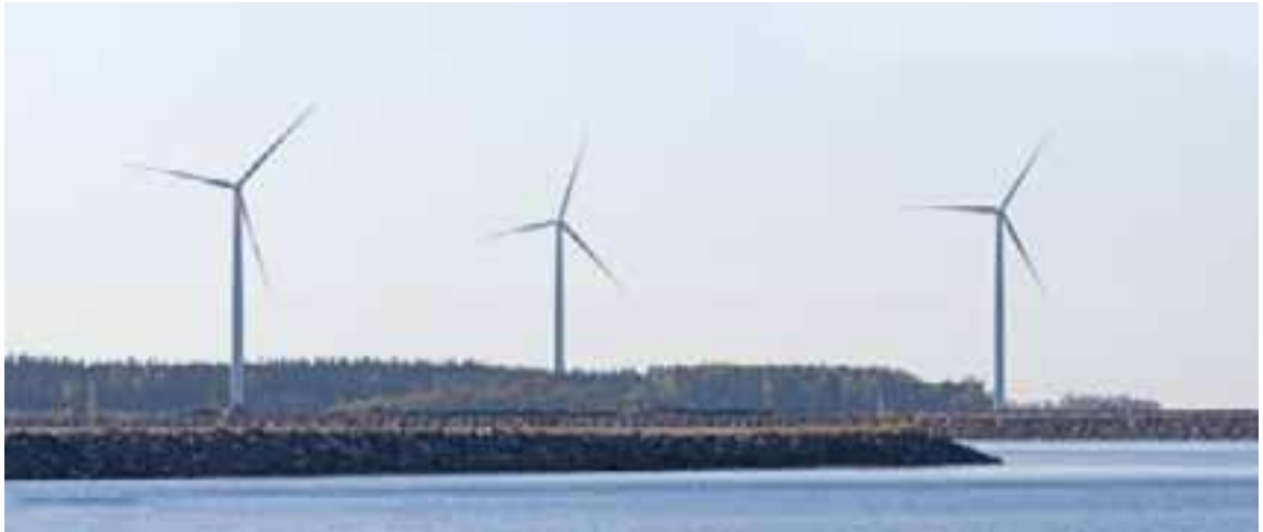
Kuva 10-25. Teräslieriörakenteisia tuulivoimaloita Raahen Lapaluodossa (Kuva © Ville Suorsa)
