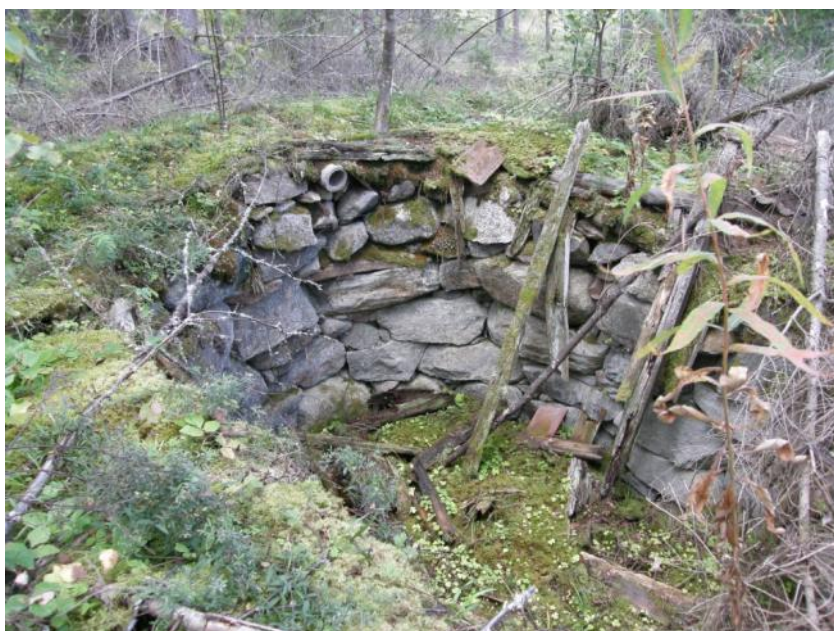
Kuva 13. Kotopellon kellarin rakenteita. 2.9.2010.
