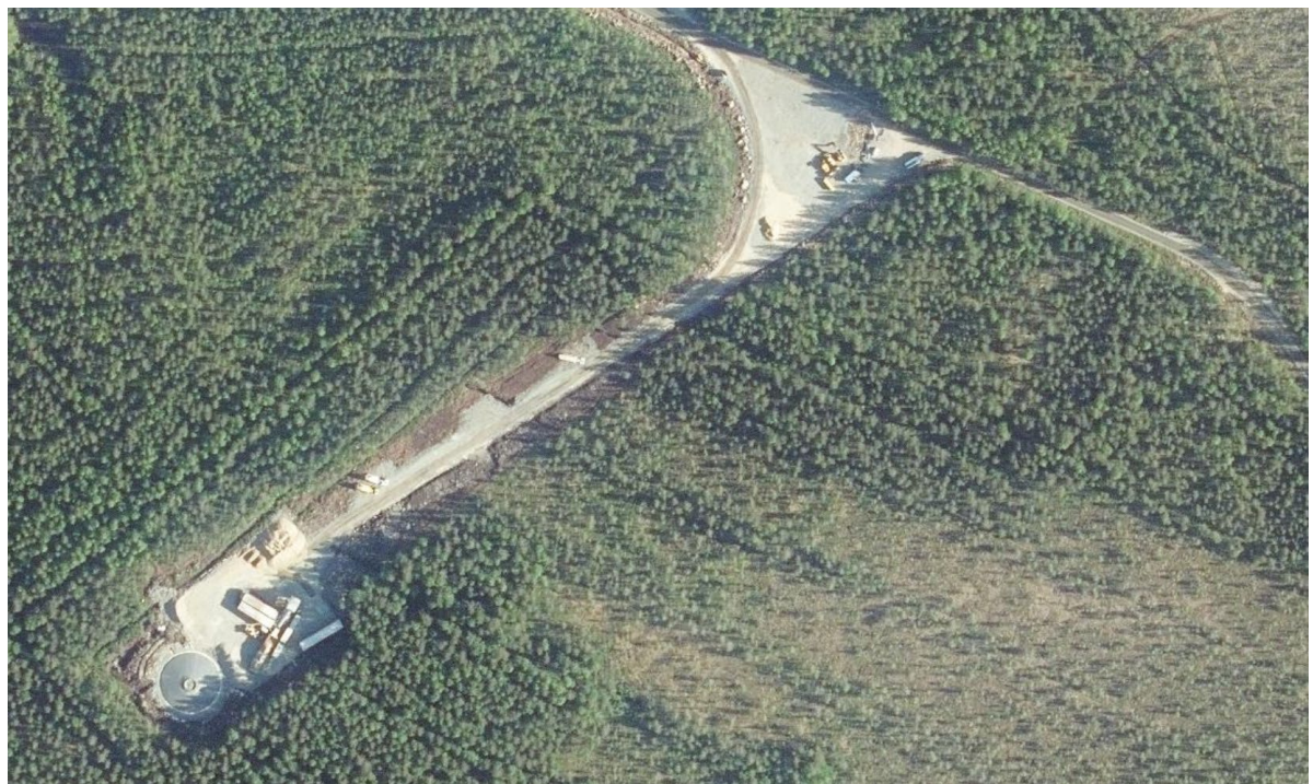
Kuva 7. Esimerkki tuulivoimalan rakennustyömaasta. Ilmakuvan lähde: MML, avoimet aineistot 2022.
