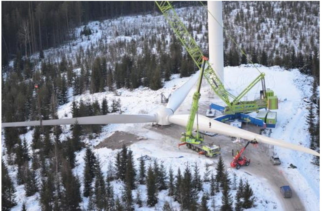
Kuva 5-5. Tuulivoimalan roottori on kasattu nostoalueelle ja odottaa nostoa. Kuvassa näkyvät ristikkopuominen päänosturi ja pienempi teleskooppipuominen apunosturi. (Silvasti 2013b)
