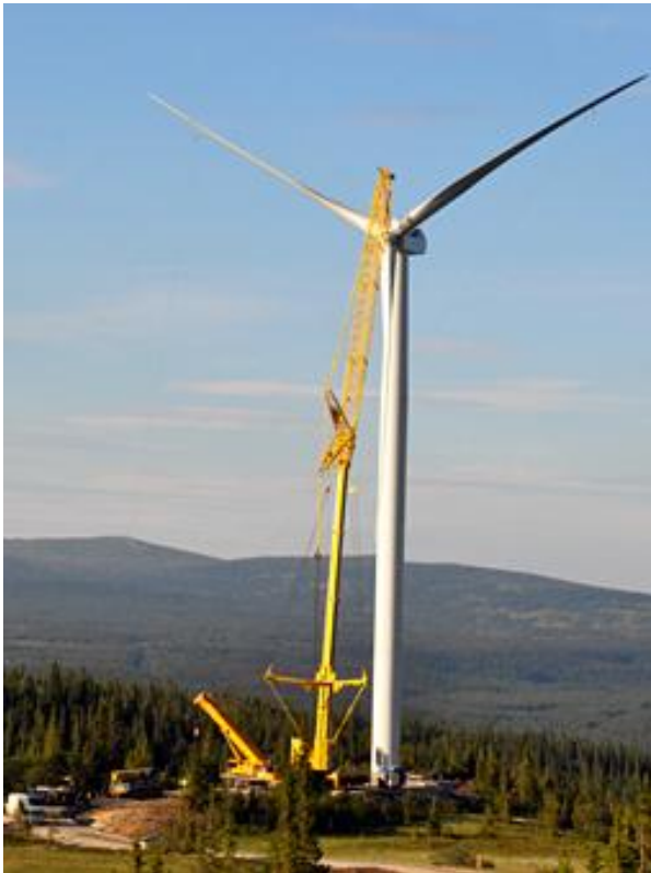
Kuva 5-6. Tuulivoimalan pystytys (Havator 2013).
